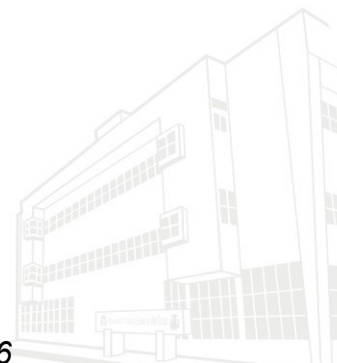
Edifício Marechal Rondon - Sede atual 2013
