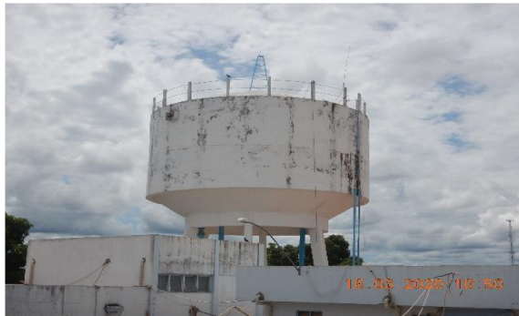
Figura 9 - Reservatório elevado da ETA
