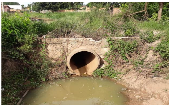
Figura 40 - Galeria e descarga em APP em processo de invasão
