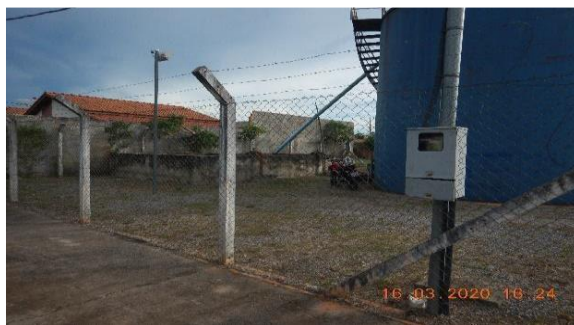
Figura 18 - Vista da ETE Aeroporto
