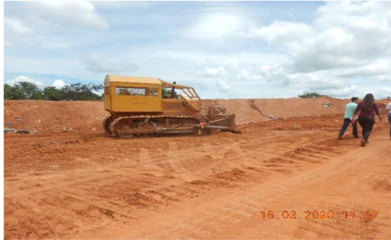
Figura 26 - Vista da via de acesso ao topo do maciço – área operacional (Aterro Sanitário)
