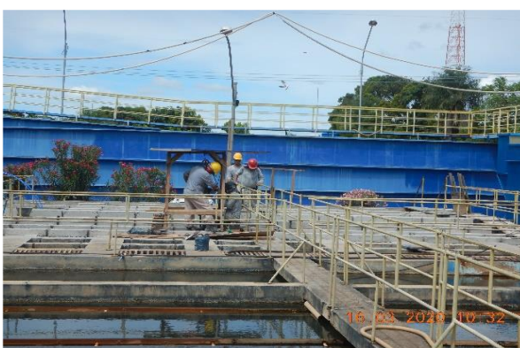
Figura 6 - Reforma na ETA de concreto
