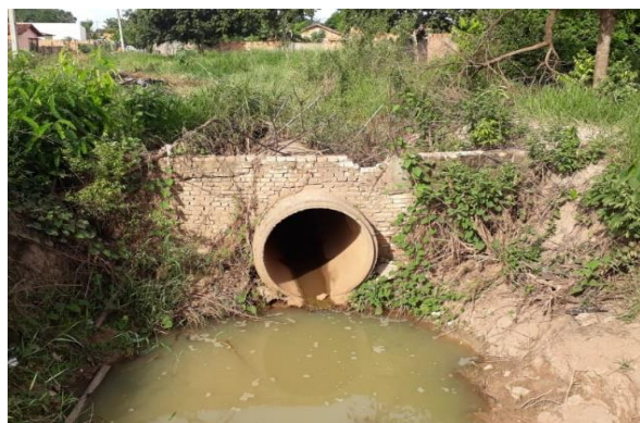
Figura 44 - Galeria e descarga em APP em processo de invasão
