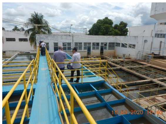
Figura 8 - Vista das ETA de concreto e metálica
