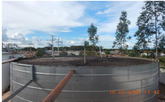
Figura 14 - Reator USAB (ETE Dom Máximo)
