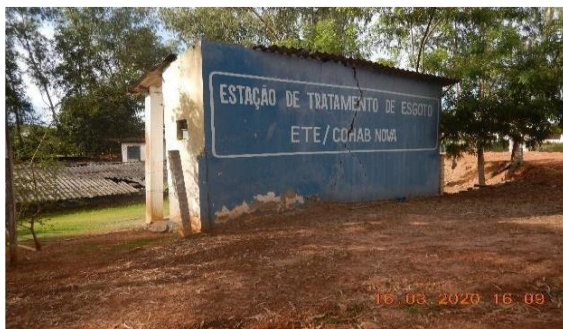
Figura 16 – Vista da ETE Cohab Nova
