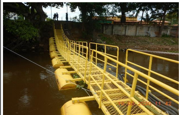
Figura 2 - Ponte metálica móvel de acesso à balsa flutuante
