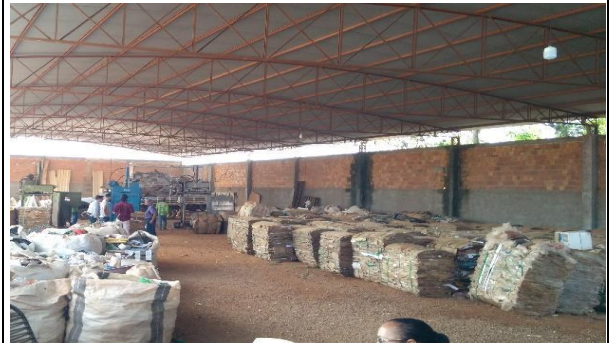
Figura 39 - Vista do galpão com caminhão ao fundo
