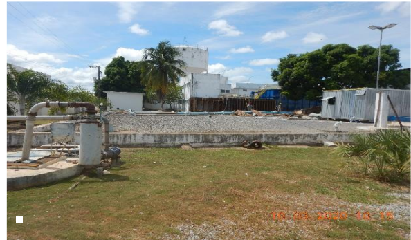
Figura 10 - Reservatório enterrado da ETA
