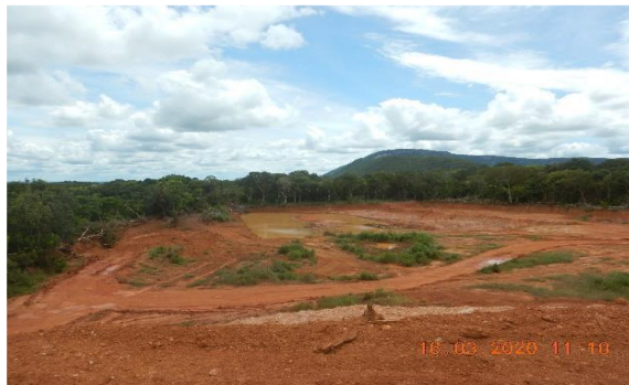
Figura 28 - Vista da área de expansão do aterro sanitário
