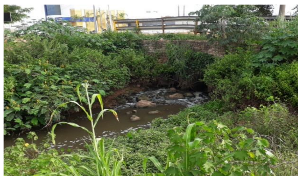
Figura 42 - Bueiro tubular no córrego Lavapés
