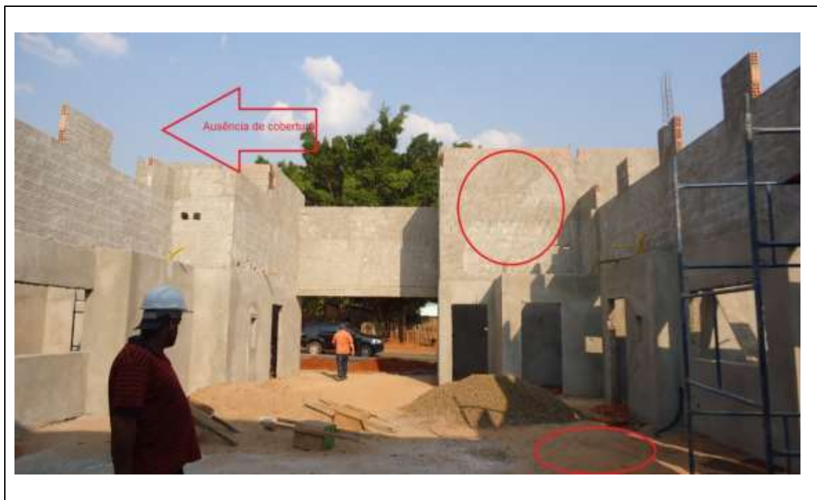
Foto: Obra da Construção do Lar dos Idosos
