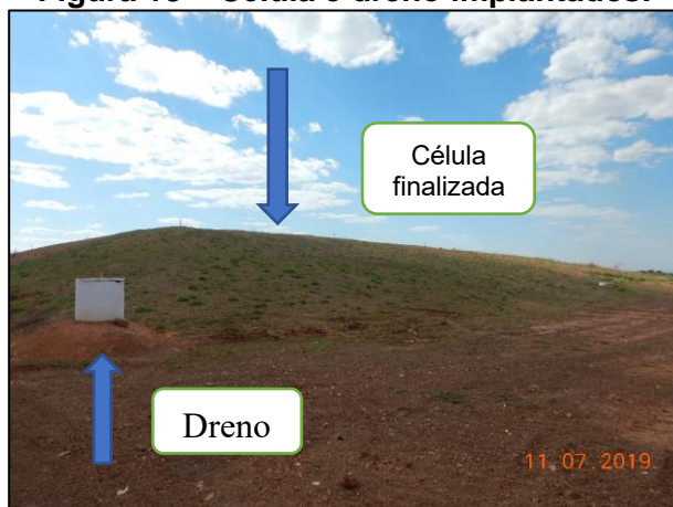
Figura 18 – Célula e dreno implantados.
