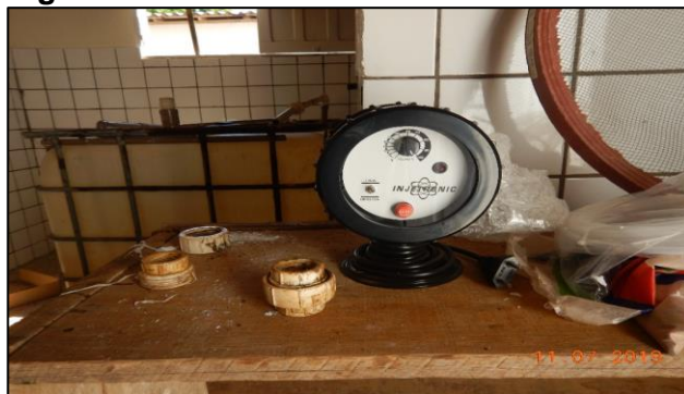
Figura 2 – Bomba dosadora não foi instalada.
