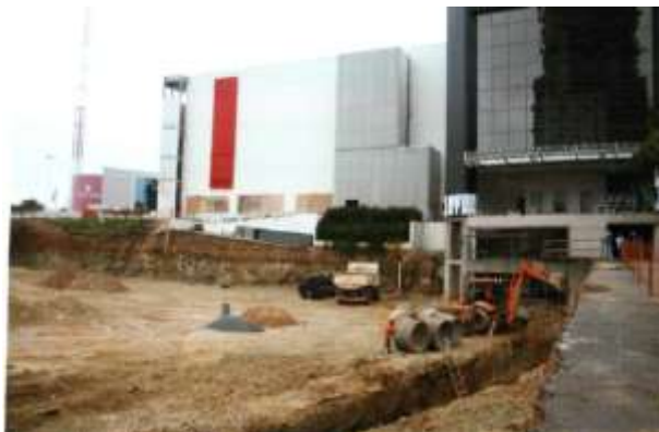
Escavação para drenagem:
