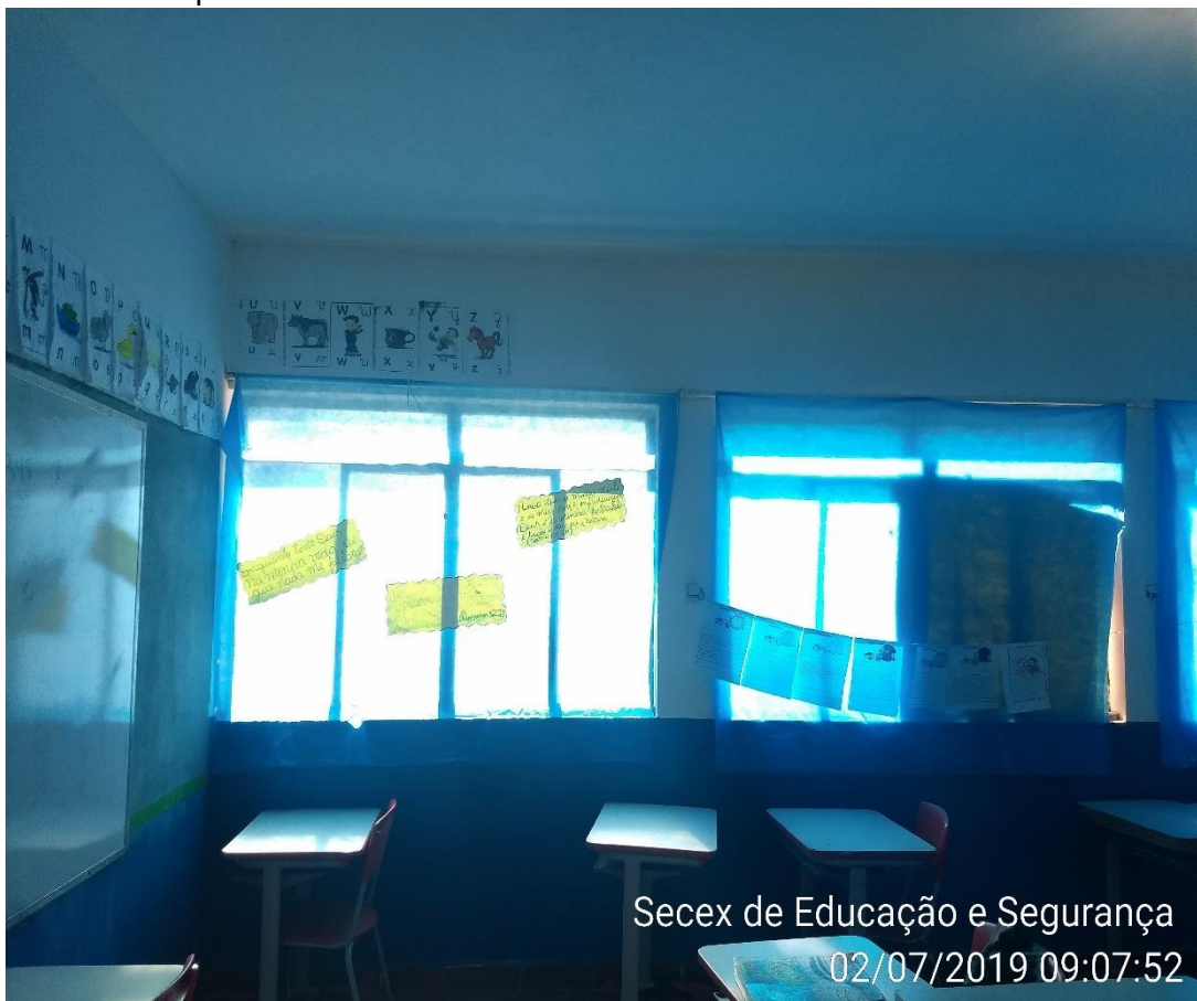
Sala de aula pintada
