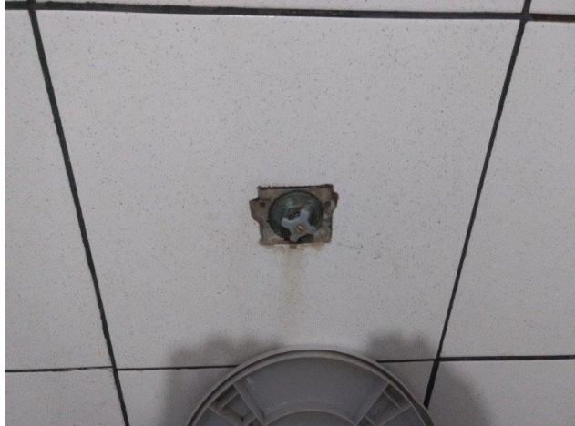
Foto: descarga danificada (sanitário masculino)
