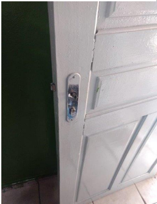
Foto: fechadura danificada – 4° ano D
