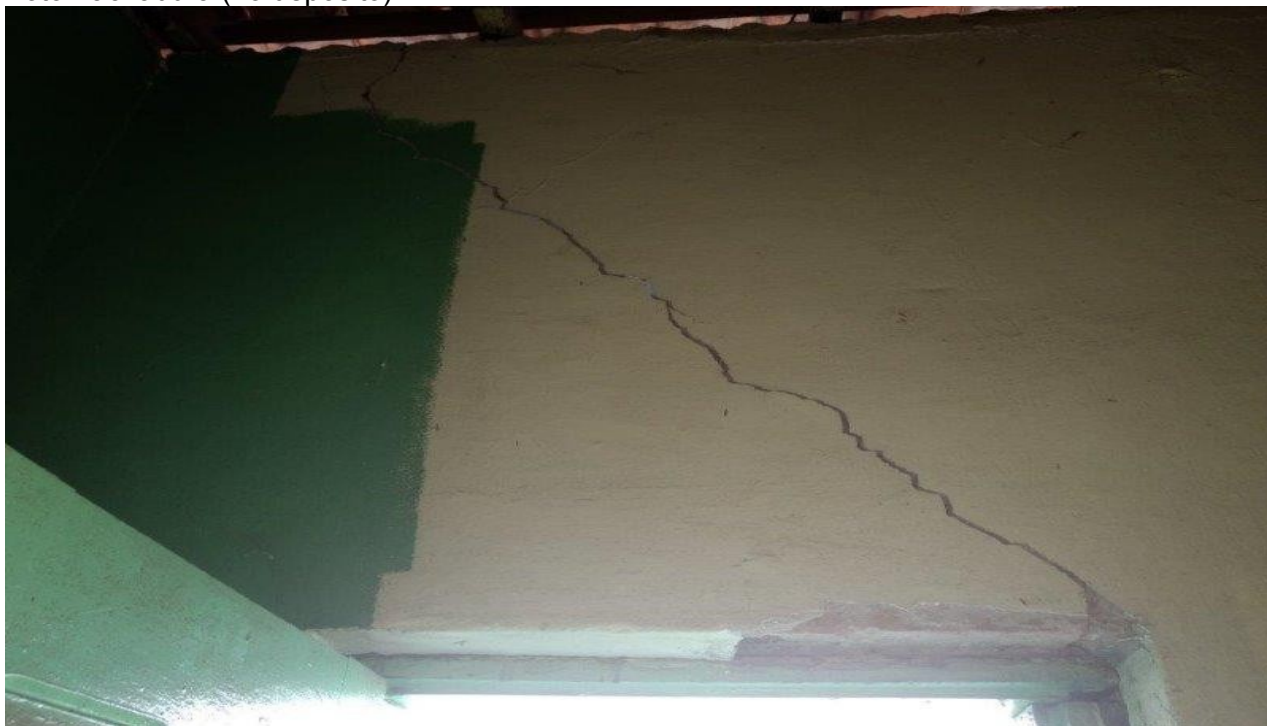
Foto: rachadura (no depósito)
