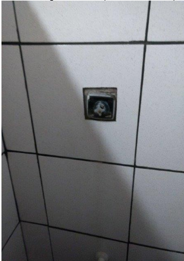
Foto: descarga danificada (sanitário feminino)
