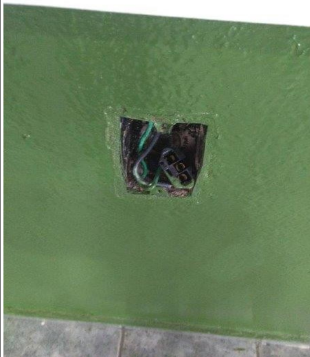
Foto: fiação exposta (sala do 4º ano A)
