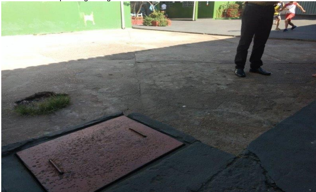
Foto: única saída para esgotar água da chuva
