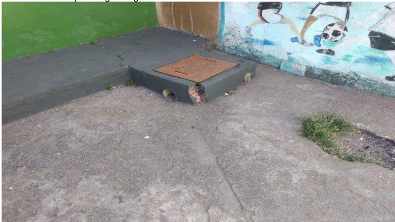
Foto: única saída para esgotar água da chuva
