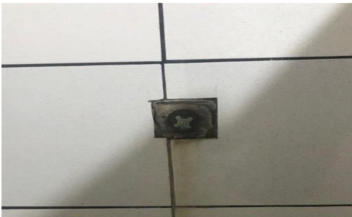
Descarga danificada (sanitários feminino e masculino)
