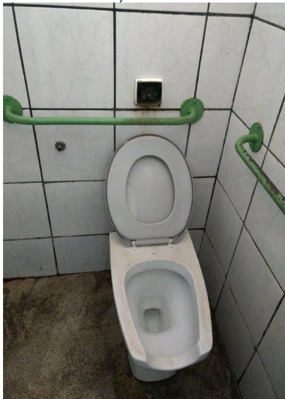
Foto: acionador de descarga danificado (sanitário masculino)
