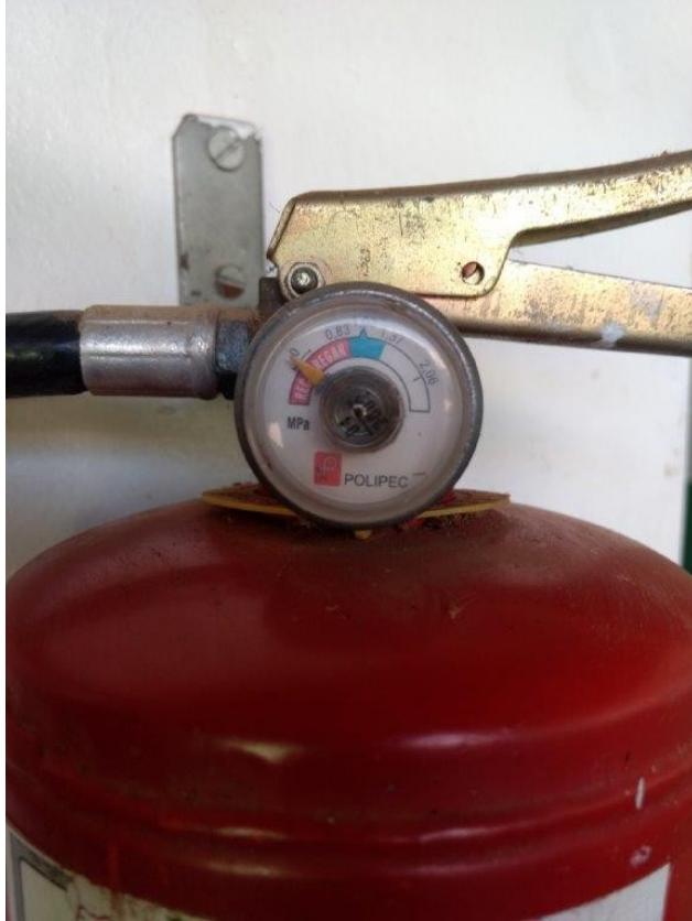
Foto: extintor 1 – vencido e despressurizado
