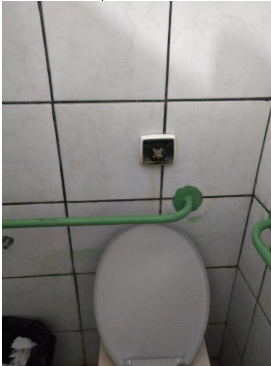
Foto: acionador de descarga danificado (sanitário feminino)
