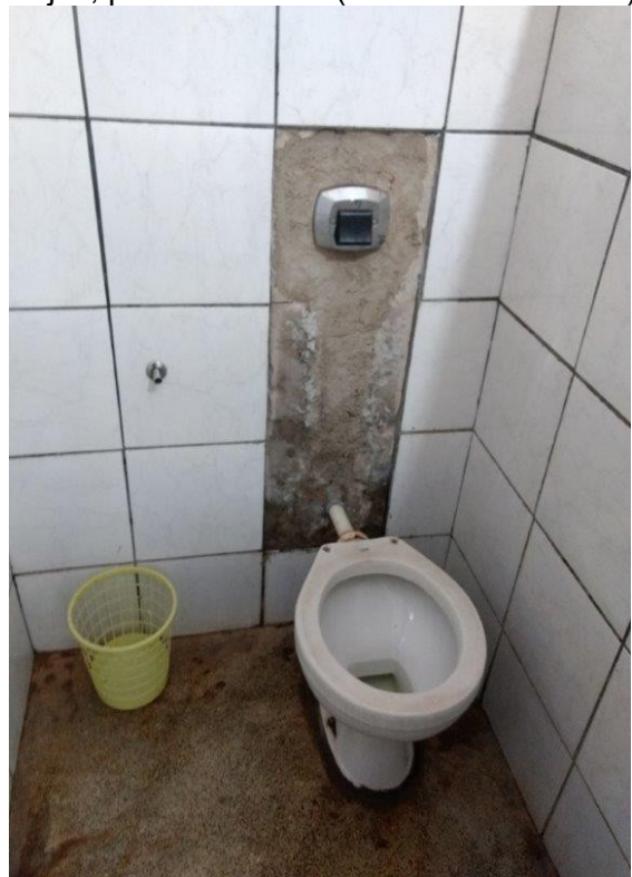
Foto: vaso sem assento e sem tampa; falta de azulejos; piso danificado (sanitário masculino)
