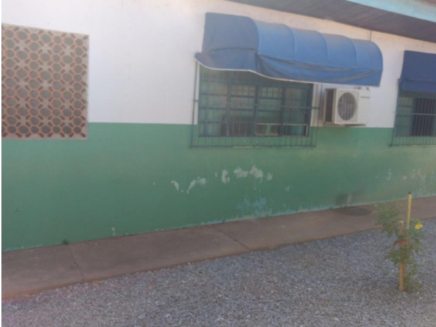
Foto: pintura danificada (externa às salas de aula)
