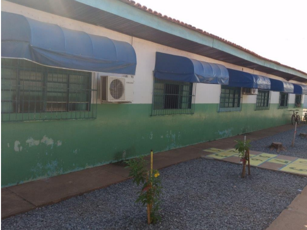
Foto: pintura danificada (4° ano B)
