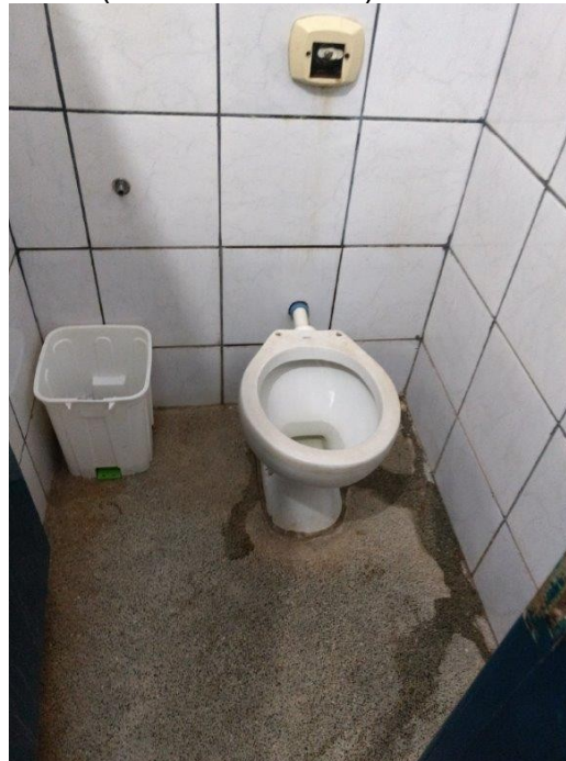
Foto: vaso sem assento e sem tampa; acionador de descarga danificado; piso danificado (sanitário feminino)
