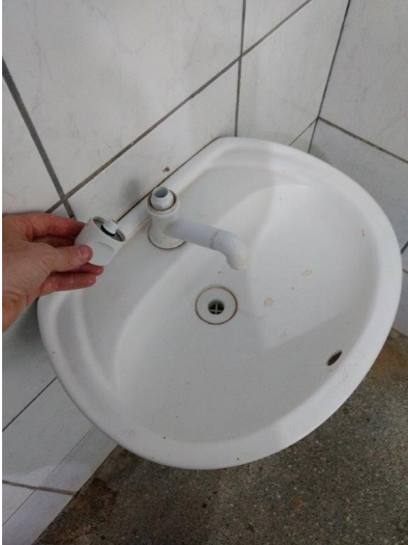
Foto: acionador de descarga danificado (sanitário feminino)
