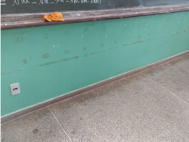
Foto: pintura danificada (4° ano B)
