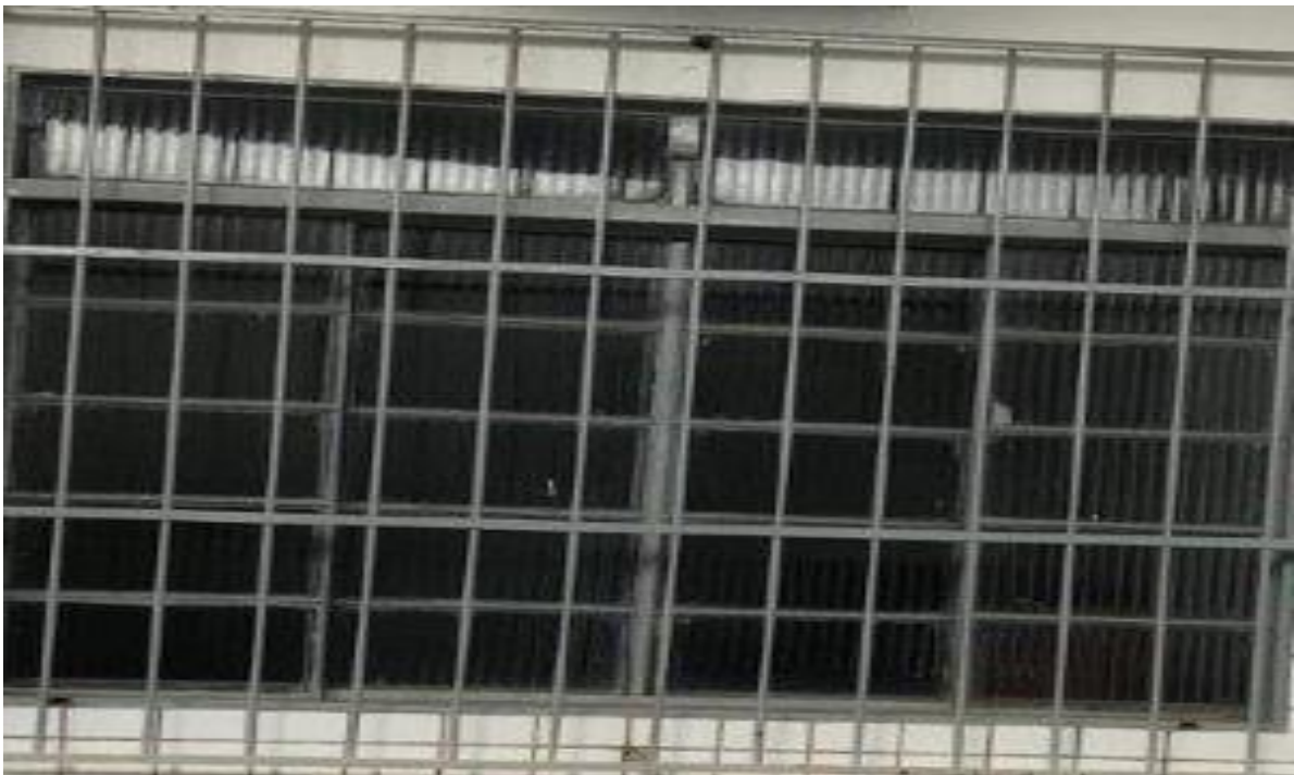
Vidraça colocada (sala 5)
