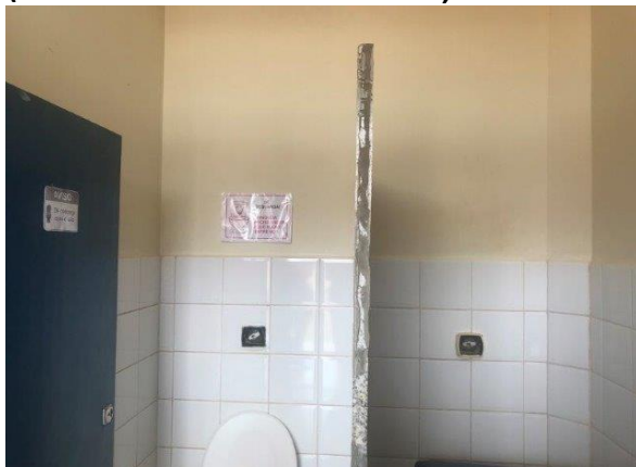
ACIONADOR DE DESCARGA DANIFICADO (SANITÁRIO DOS FUNCIONÁRIOS)
