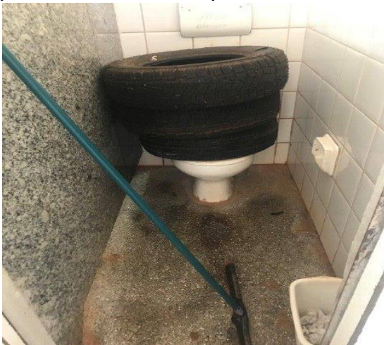
VASO INTERDITADO (SANITÁRIO MASCULINO)
