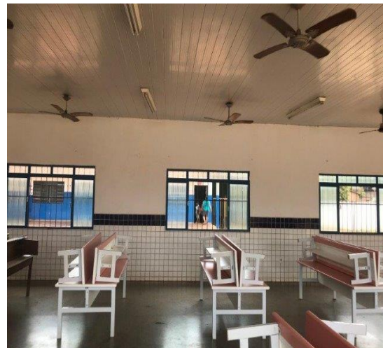
VIDRAÇA DO REFEITÓRIO CONSERTADA
