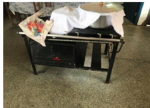
FOGÃO COM INSTALAÇÃO DE GÁS FORA DA COZINHA
