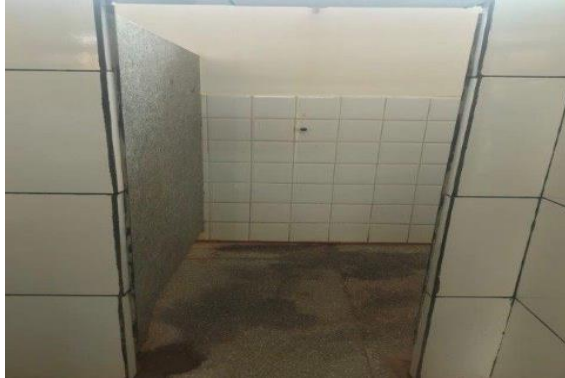
FALTA DE PORTA NO BOX E PISO DANIFICADO (SANITÁRIO MASCULINO)
