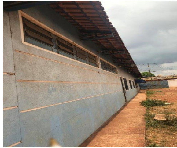
PAREDES COM PINTURA ENVELHECIDA
