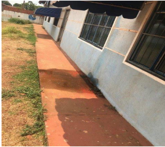
PAREDES COM PINTURA DESGASTADA
