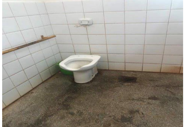
VASO SEM ASSENTO E SEM TAMPA (SANITÁRIO MASCULINO-acessibilidade)
