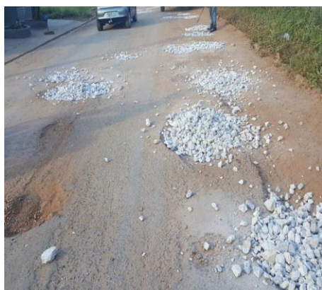
Fonte: Fotos da 1ª medição do serviço de tapa-buraco
