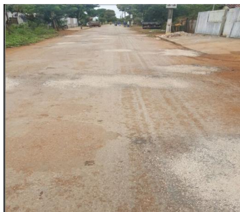
Fonte: Fotos da 2ª medição do serviço de tapa-buraco
