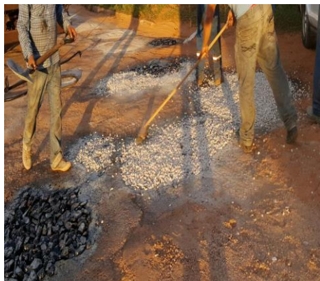
Fonte: Fotos da 1ª medição do serviço de tapa-buraco
