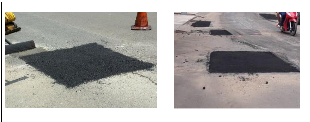
Padrão para execução de serviço de tapa-buraco
