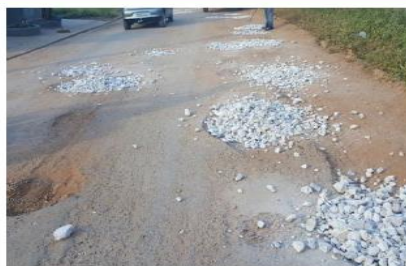
Fonte: Fotos da 1ª medição do serviço de tapa-buraco
