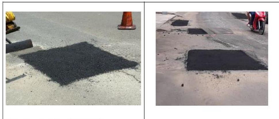
Padrão para execução de serviço de tapa-buraco
