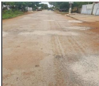
Fonte: Fotos da 2ª medição do serviço de tapa-buraco
