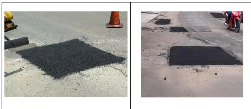
Padrão para execução de serviço de tapa-buraco
