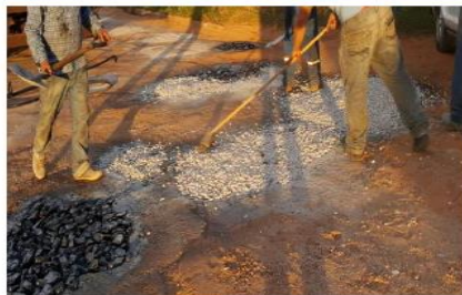
Fonte: Fotos da 1ª medição do serviço de tapa-buraco
