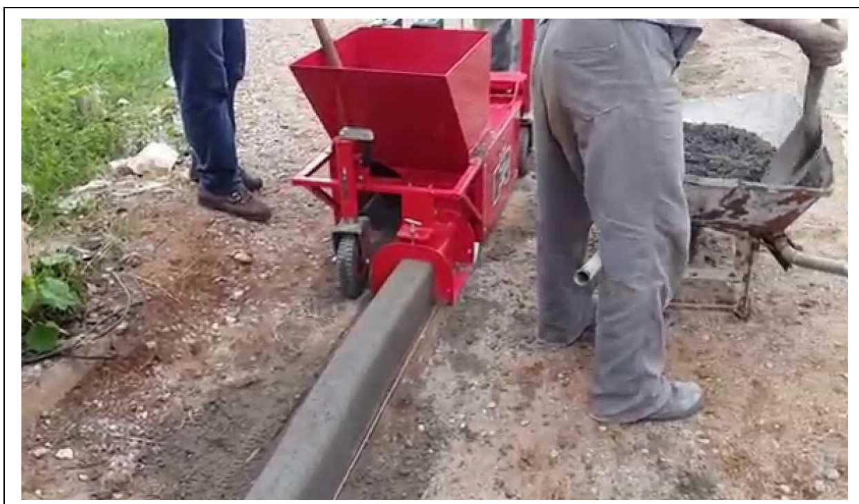
Meio-fio executado in loco por meio de extrusora de meio fio
