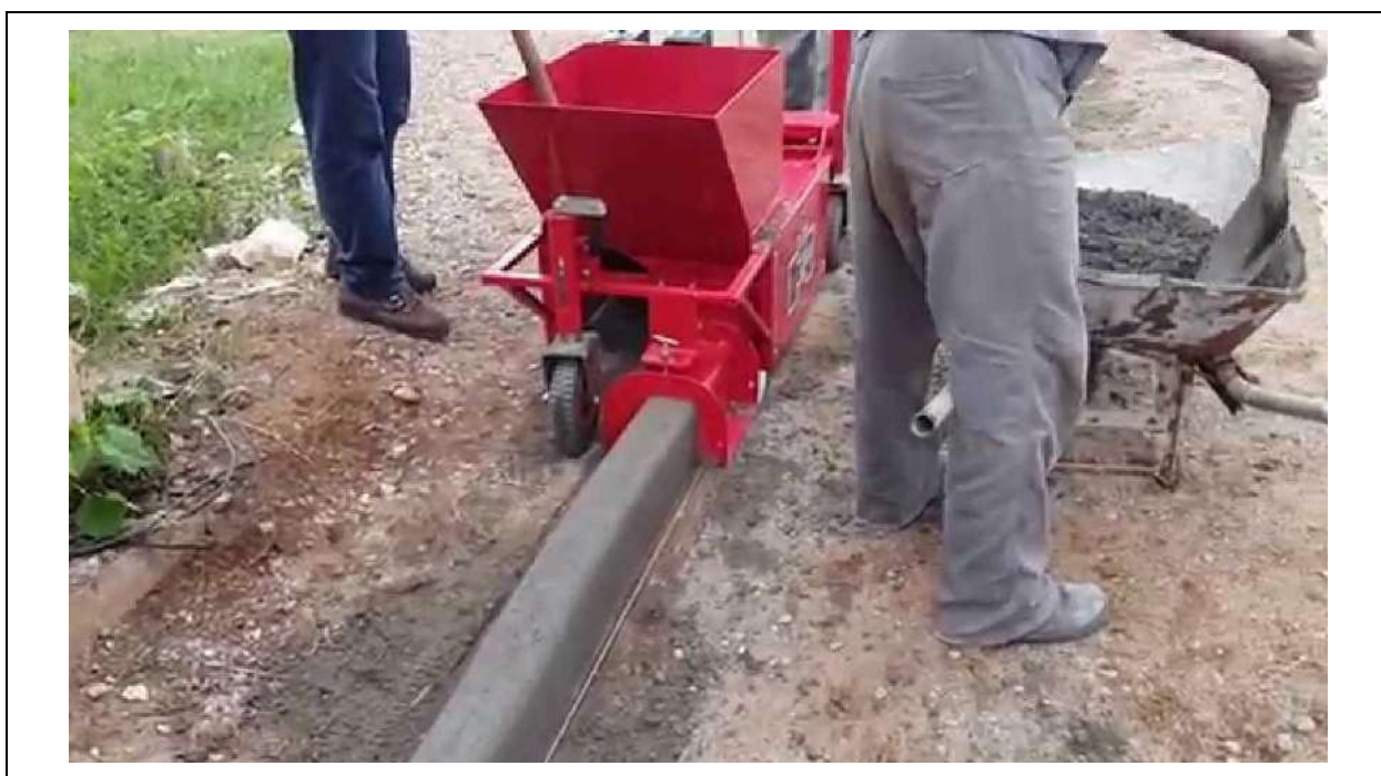
Meio-fio executado in loco por meio de extrusora de meio fio
