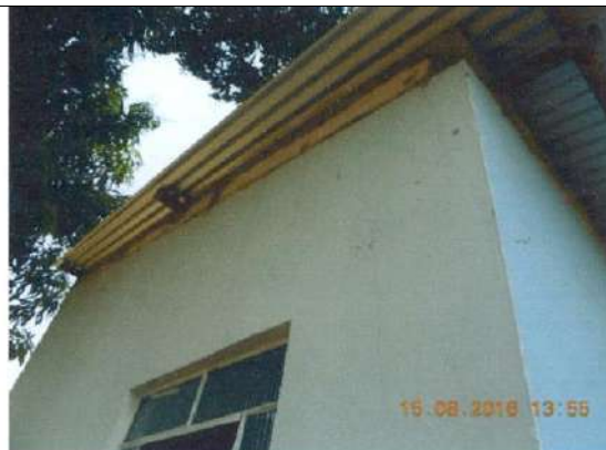
Foto após execução de serviço de estrutura metálica e telha de zinco para cobertura DAE.
