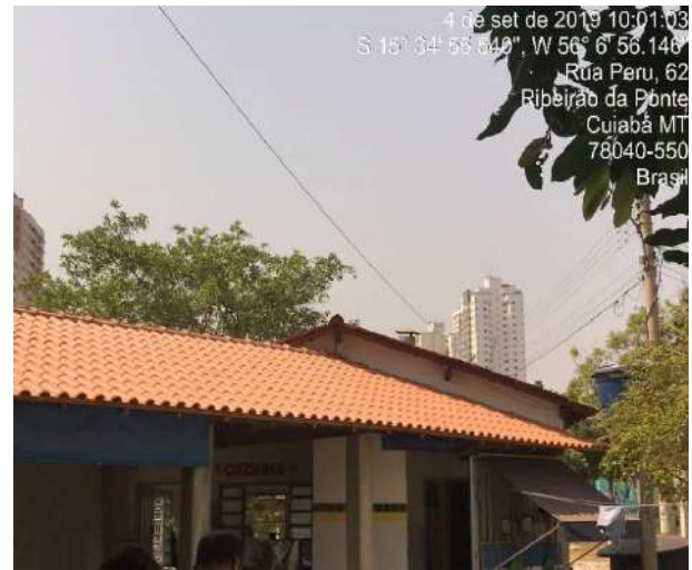
Cobertura da Creche
