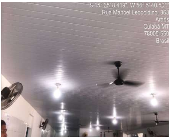
Ventiladores e forros reformados
