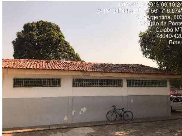
Cobertura existente em cerâmica
