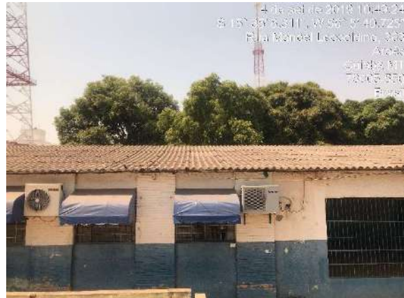
Situação da cobertura de telha de fibrocimento
