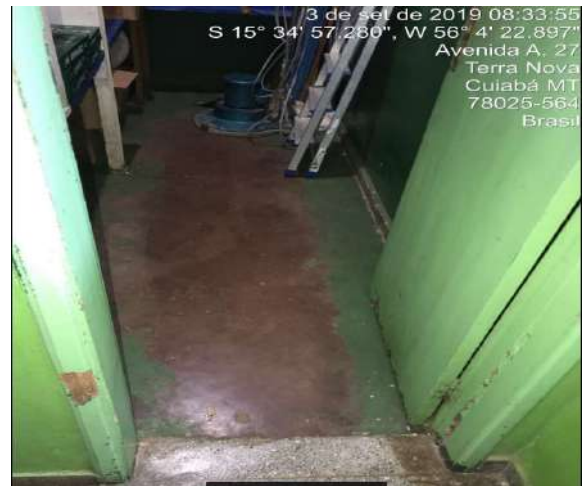
Parte do piso em granilite e outra parte em cimento queimado
