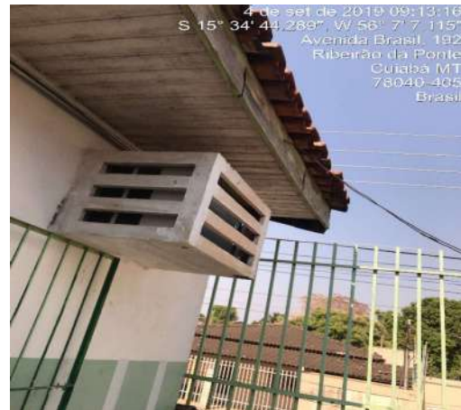
Trecho do madeiramento da cobertura
