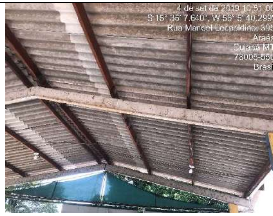
Área externa coberta
