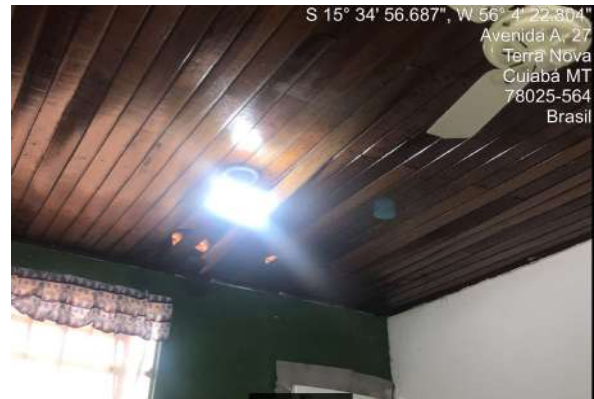
Parte do forro existente
