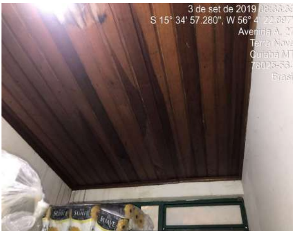
Situação do forro em madeira existente
