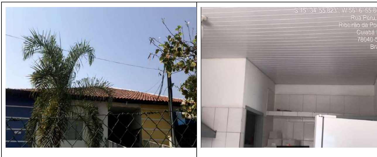
Relatório fotográfico – parte do telhado e forro –Creche Macaria Militona.
