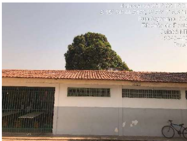
Cobertura existente em cerâmica
