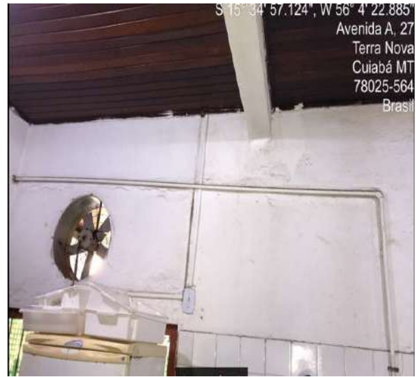
Tubulação elétrica aparente reformada
