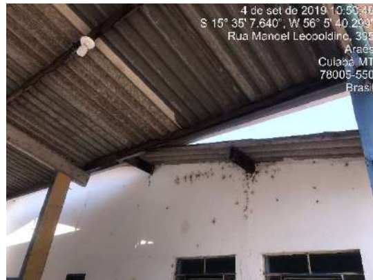
Telha de fibrocimento
