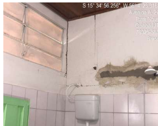
Tubulação elétrica aparente reformada
