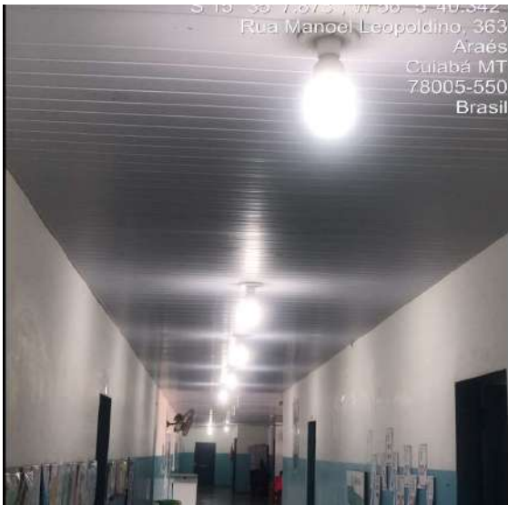
Parte do forro em PVC e lâmpadas
