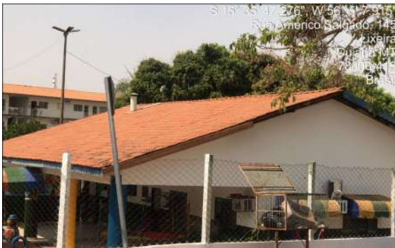
Telhado da Creche Dona Micaela
