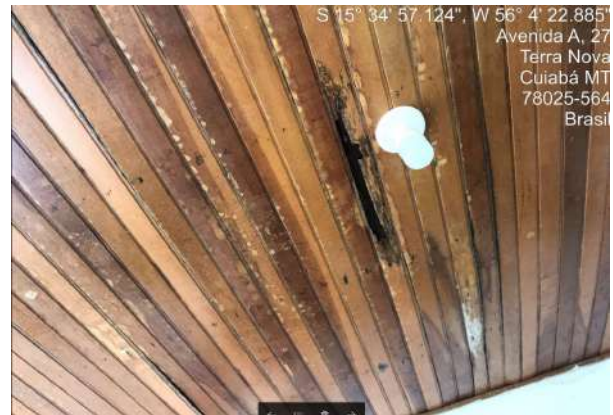
Forro em madeira existente
