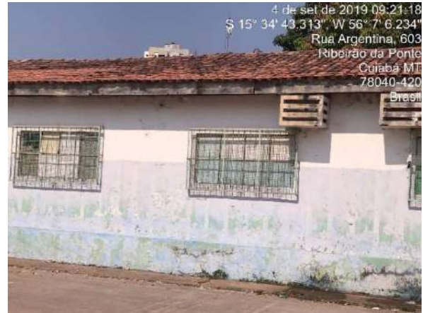
Pintura da parte externa
