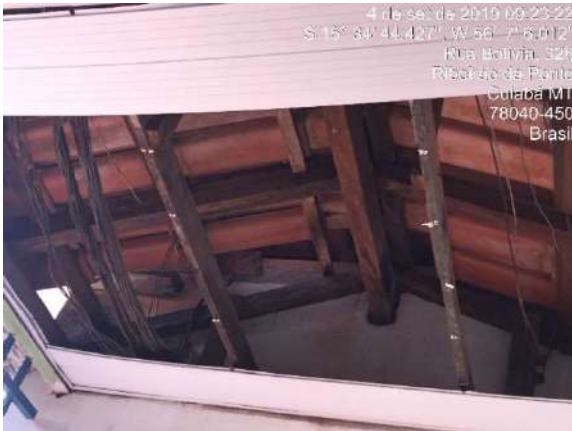
Telhas e madeiramento
