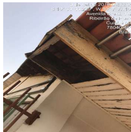
Trecho do madeiramento da cobertura
