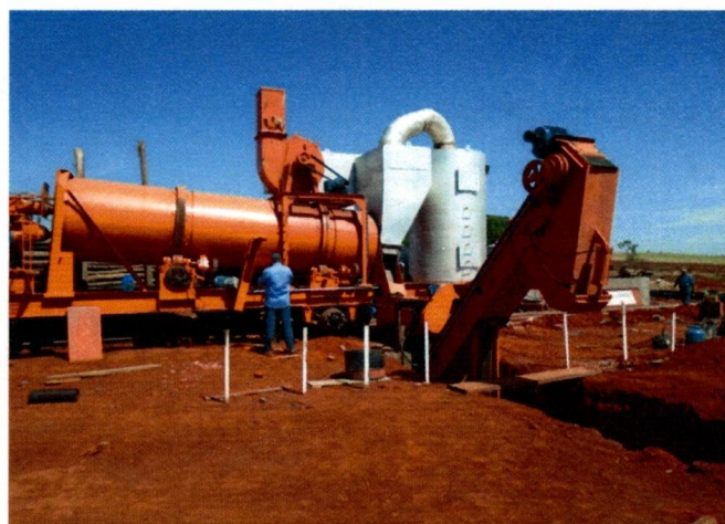
Foto 25 – Montagem Usina de CBUQ
