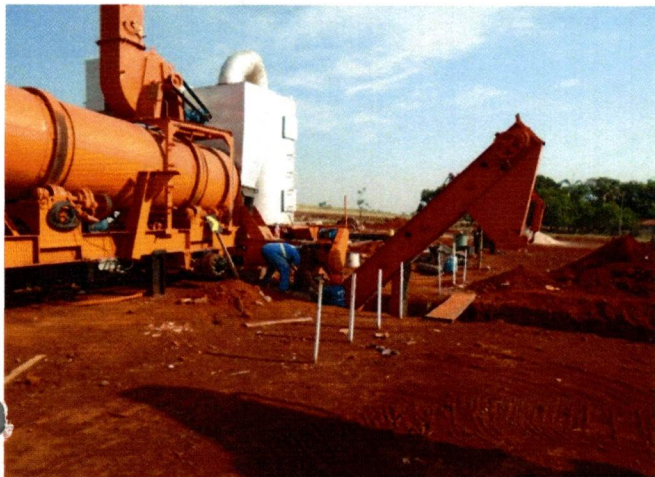
Foto 20 – Montagem Usina de CBUQ
