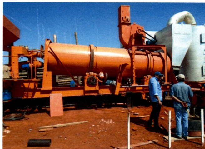
Foto 23 – Montagem Usina de CBUQ
