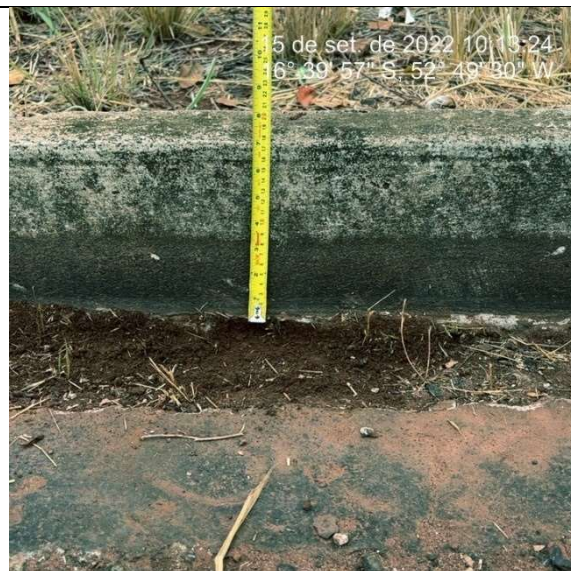
Imagem 3626. Altura inferior e 25cm, definida no projeto. Sarjeta com espessura inferior a 10cm definida no projeto
