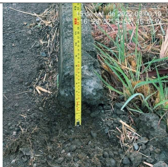
Imagem 3551. Altura inferior e 25cm definida no projeto. Ausência de sarjeta – meio-fio ancorado diretamente no acostamento de TSD.
