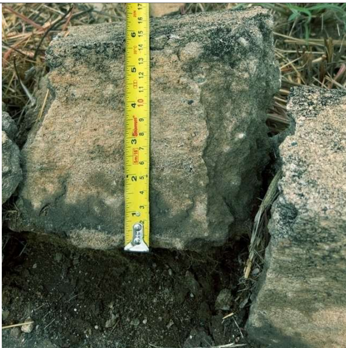
Imagem 3598. Altura inferior e 25cm definida no projeto. Ausência de sarjeta.
