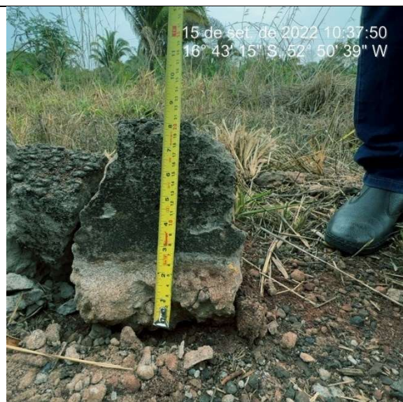
Imagem 3640. Altura inferior e 25cm, definida no projeto. Ausência de sarjeta.
