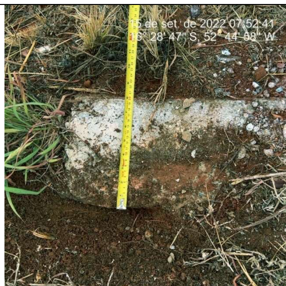
Imagem 3549. Altura inferior e 25cm definida no projeto. Ausência de sarjeta
