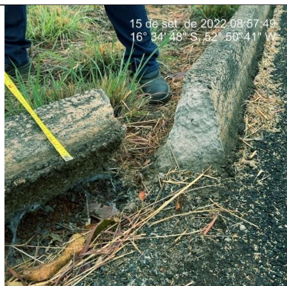
Imagem 3572. Ausência de sarjeta. Meio-fio assentado sobre o acostamento em TSD, quando o Projeto e a Norma DNIT 020/2006-ES, determina a escavação do bordo do pavimento. No caso deste contrato, a escavação do bordo do acostamento deveria comportar a sarjeta do meio-fio, ou seja, a profundidade escavada deveria ser de 12cm.
