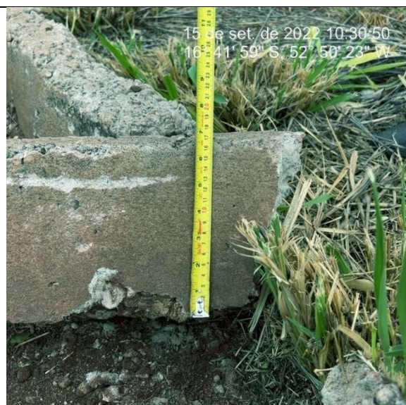
Imagem 3633. Altura inferior e 25cm definida no projeto. Ausência de sarjeta.
