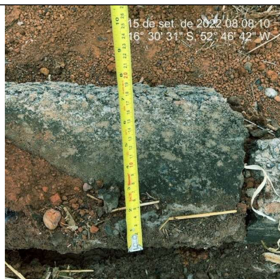
Imagem 3552. Altura inferior e 25cm, definida no projeto. Sarjeta com espessura inferior a 10cm definida no projeto.
