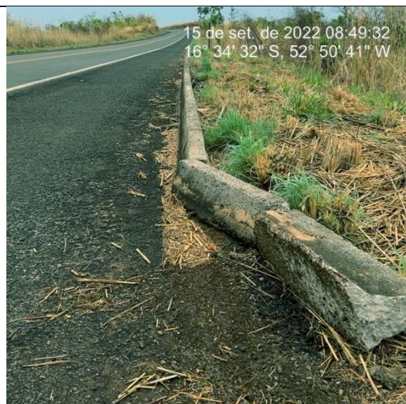
Imagem 3568. Ausência de sarjeta. Meio-fio assentado sobre o acostamento em TSD, quando o Projeto e a Norma DNIT 020/2006-ES, determina a escavação do bordo do pavimento. No caso deste contrato, a escavação do bordo do acostamento deveria comportar a sarjeta do meio-fio, ou seja, a profundidade escavada deveria ser de 12cm.
