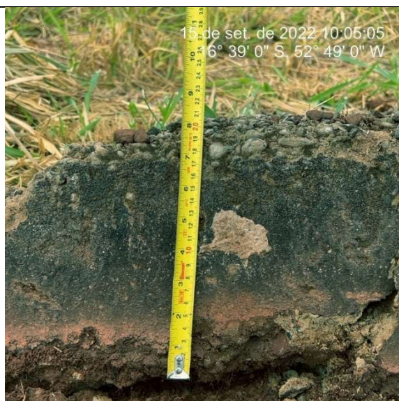
Imagem 3622. Altura inferior e 25cm definida no projeto. Ausência de sarjeta.
