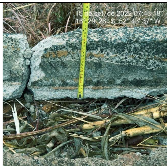
Imagem 3546. Altura inferior e 25cm, definida no projeto. Sarjeta com espessura inferior a 10cm definida no projeto.
