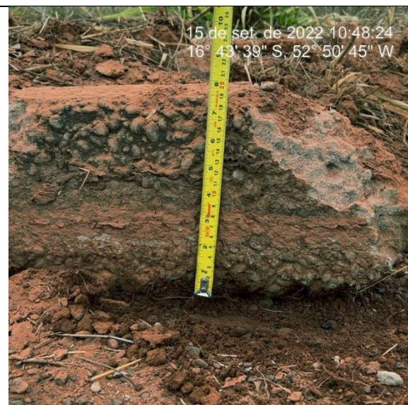
Imagem 3646. Altura inferior e 25cm definida no projeto. Ausência de sarjeta.
