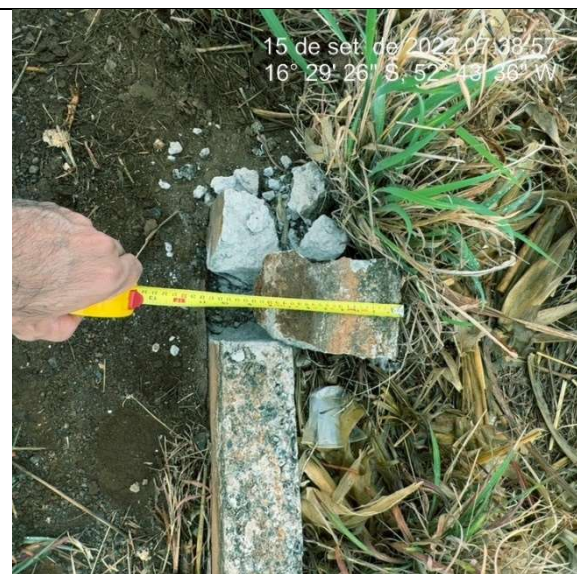
Imagem 3544. Altura inferior e 25cm definida no projeto. Ausência de sarjeta – meio-fio ancorado diretamente no acostamento de TSD.
