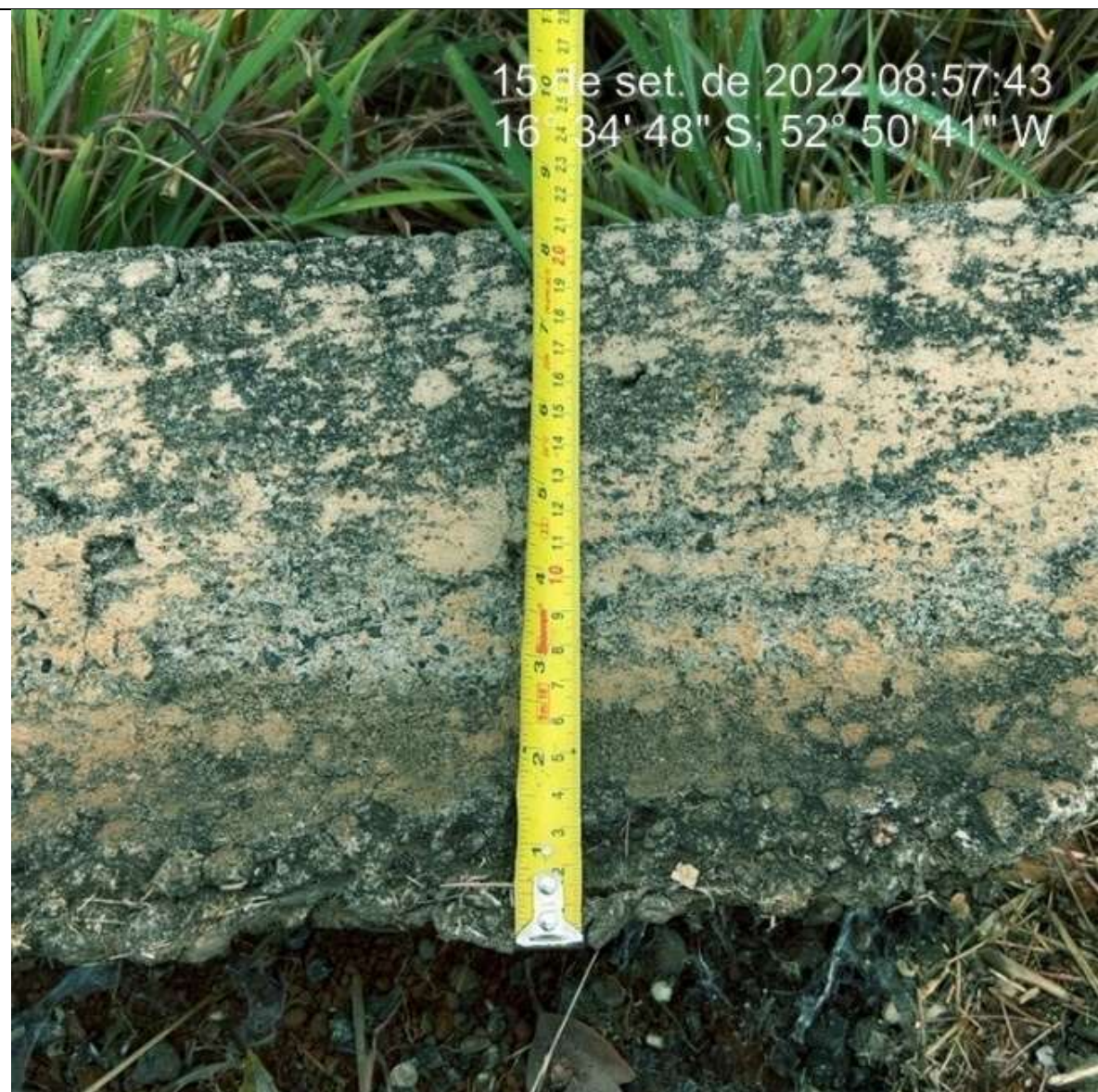
Imagem 3571. Altura inferior e 25cm definida no projeto. Ausência de sarjeta.
