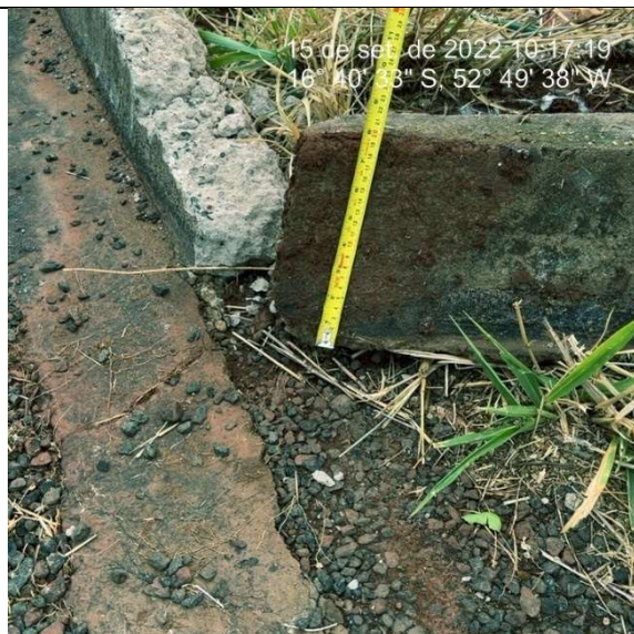
Imagem 3627. Altura inferior e 25cm definida no projeto. Sarjeta com espessura inferior a 10cm, definida no projeto.
