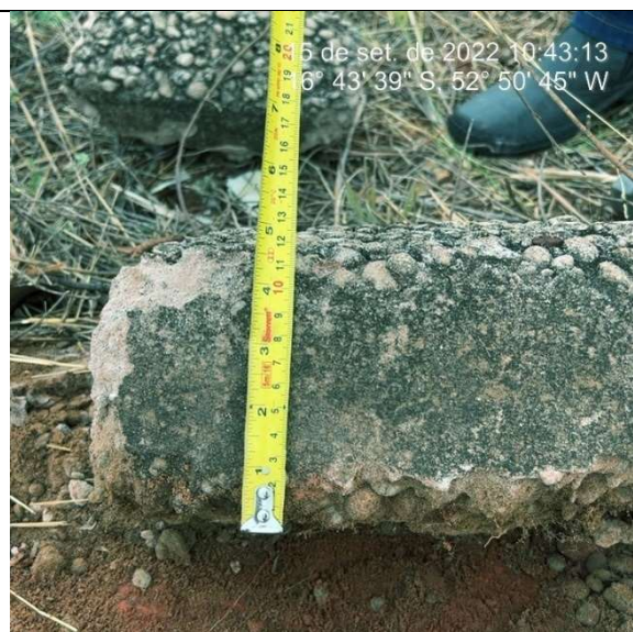
Imagem 3645. Altura inferior e 25cm definida no projeto. Ausência de sarjeta.
