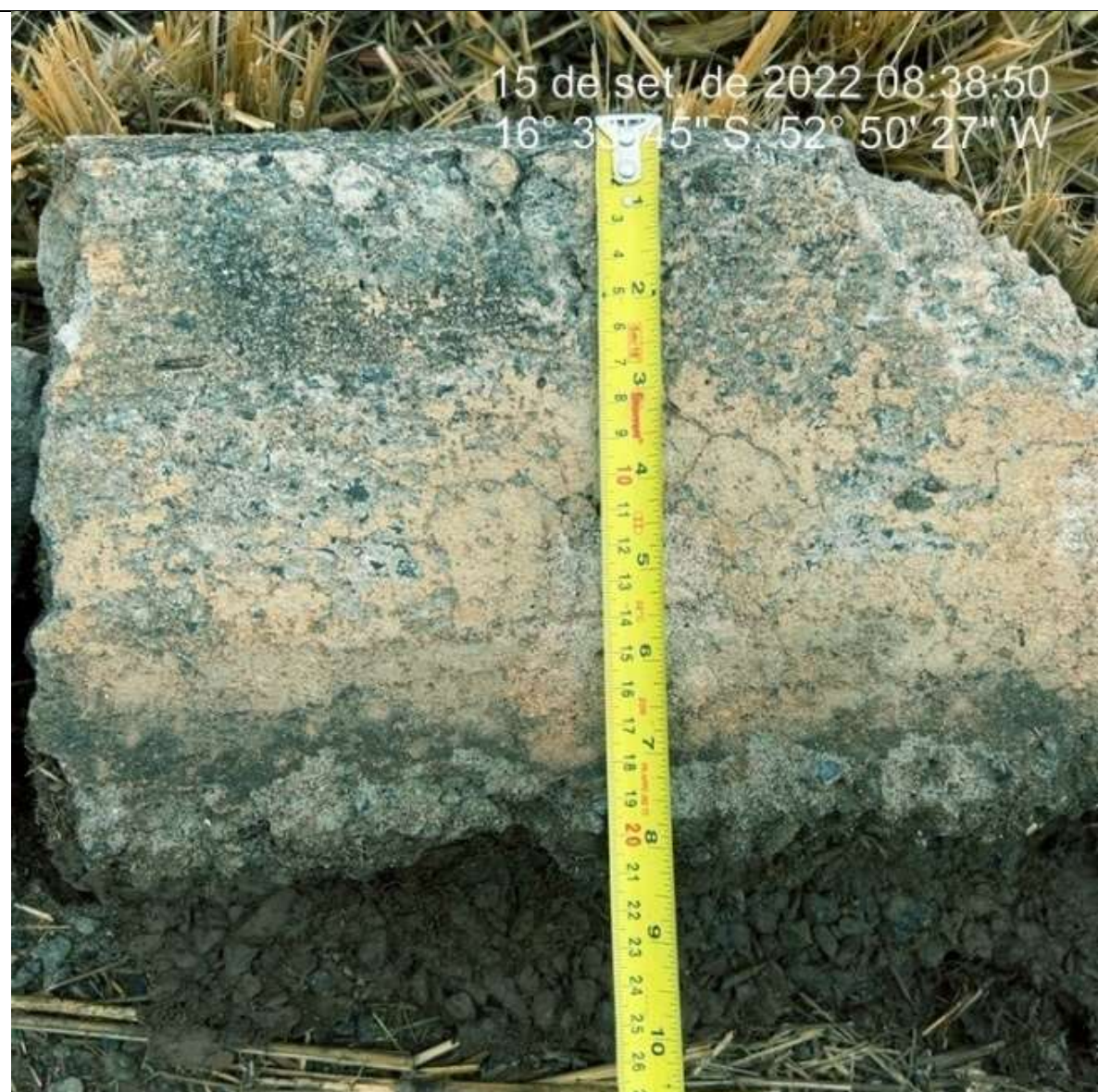
Imagem 3559. Altura inferior e 25cm definida no projeto. Ausência de sarjeta.
