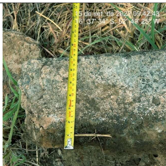
Imagem 3603. Altura inferior e 25cm definida no projeto. Ausência de sarjeta.
