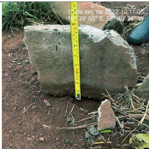
Imagem 3624. Altura inferior e 25cm definida no projeto. Ausência de sarjeta.
