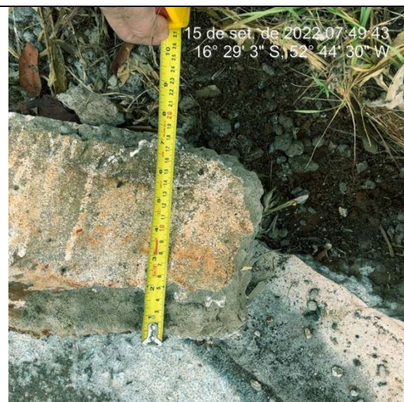
Imagem 3548. Altura inferior e 25cm, definida no projeto. Sarjeta com espessura inferior a 10cm definida no projeto.
