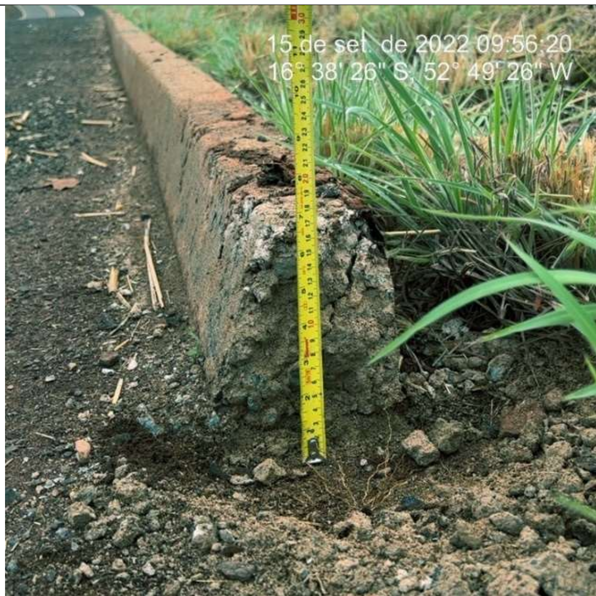
Imagem 3617. Altura inferior e 25cm definida no projeto. Ausência de sarjeta.
