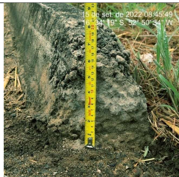
Imagem 3563. Altura inferior e 25cm definida no projeto. Ausência de sarjeta – meio-fio ancorado diretamente no acostamento de TSD
