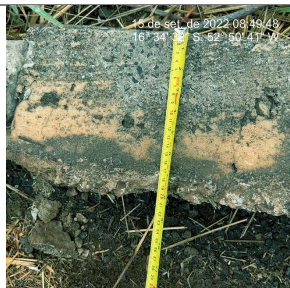
Imagem 3569. Altura inferior e 25cm definida no projeto. Ausência de sarjeta.
