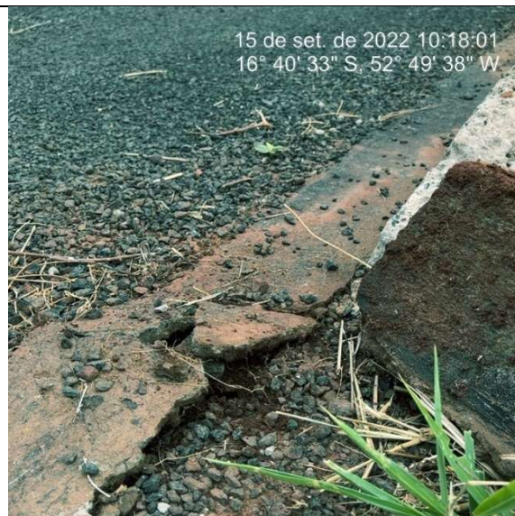
Imagem 3628. Sarjeta com espessura inferior a 10cm, definida no projeto.
