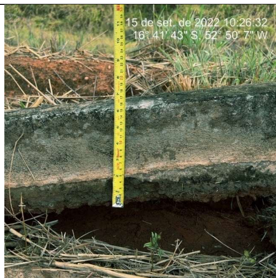
Imagem 3630. Altura inferior e 25cm definida no projeto. Sarjeta com espessura inferior a 10cm definida no projeto.
