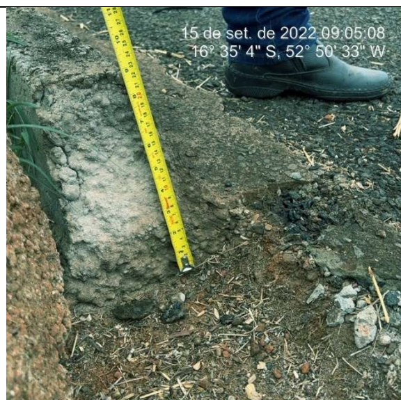
Imagem 3574. Altura inferior e 25cm definida no projeto. Sarjeta com espessura inferior a 10cm definida no projeto.
