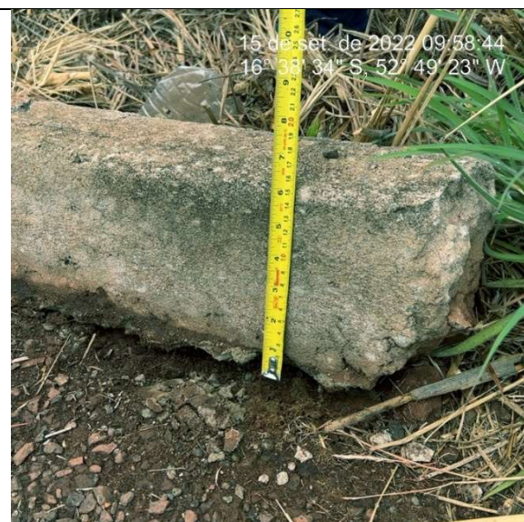
Imagem 3619. Altura inferior e 25cm definida no projeto. Ausência de sarjeta.
