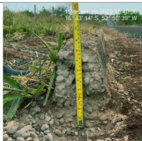
Imagem 3644. Altura inferior e 25cm definida no projeto. Ausência de sarjeta – meio-fio ancorado diretamente no acostamento de TSD.
