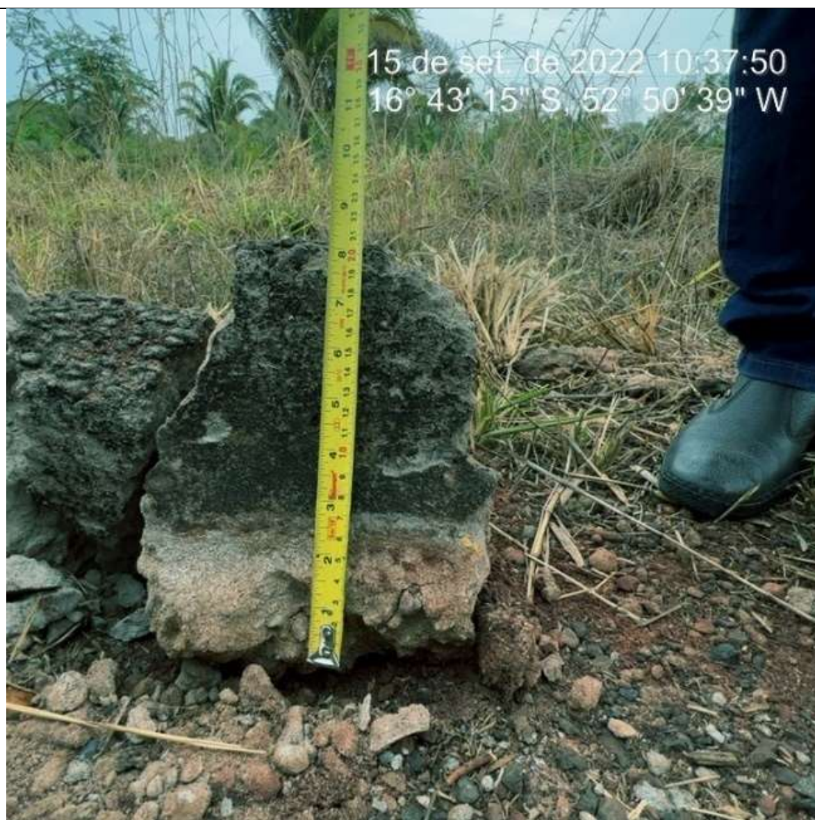
Imagem 3640. Altura inferior a 25cm, definida no projeto. Ausência de sarjeta.
