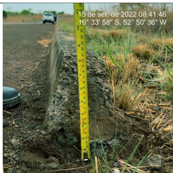
Imagem 3562. Altura inferior e 25cm definida no projeto. Ausência de sarjeta – meio-fio ancorado diretamente no acostamento de TSD.
