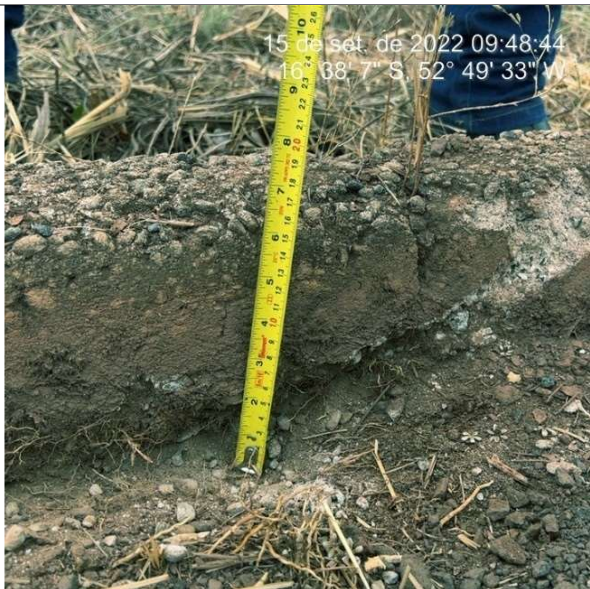
Imagem 3609. Altura inferior e 25cm definida no projeto. Ausência de sarjeta.
