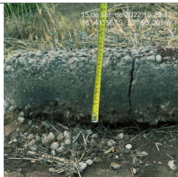
Imagem 3631. Altura inferior e 25cm definida no projeto. Sarjeta com espessura inferior a 10cm definida no projeto.
