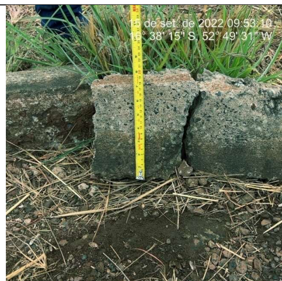
Imagem 3616. Altura inferior e 25cm definida no projeto. Ausência de sarjeta.
