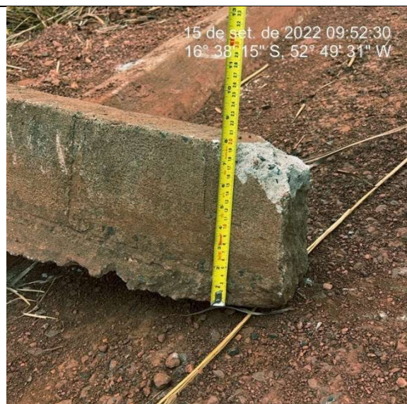
Imagem 3615. Altura inferior e 25cm definida no projeto. Ausência de sarjeta.
