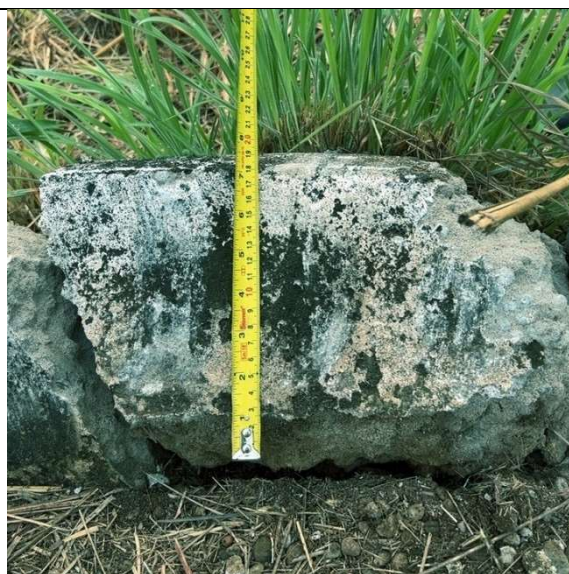
Imagem 3597. Altura inferior e 25cm, definida no projeto. Sarjeta com espessura inferior a 10cm definida no projeto.
