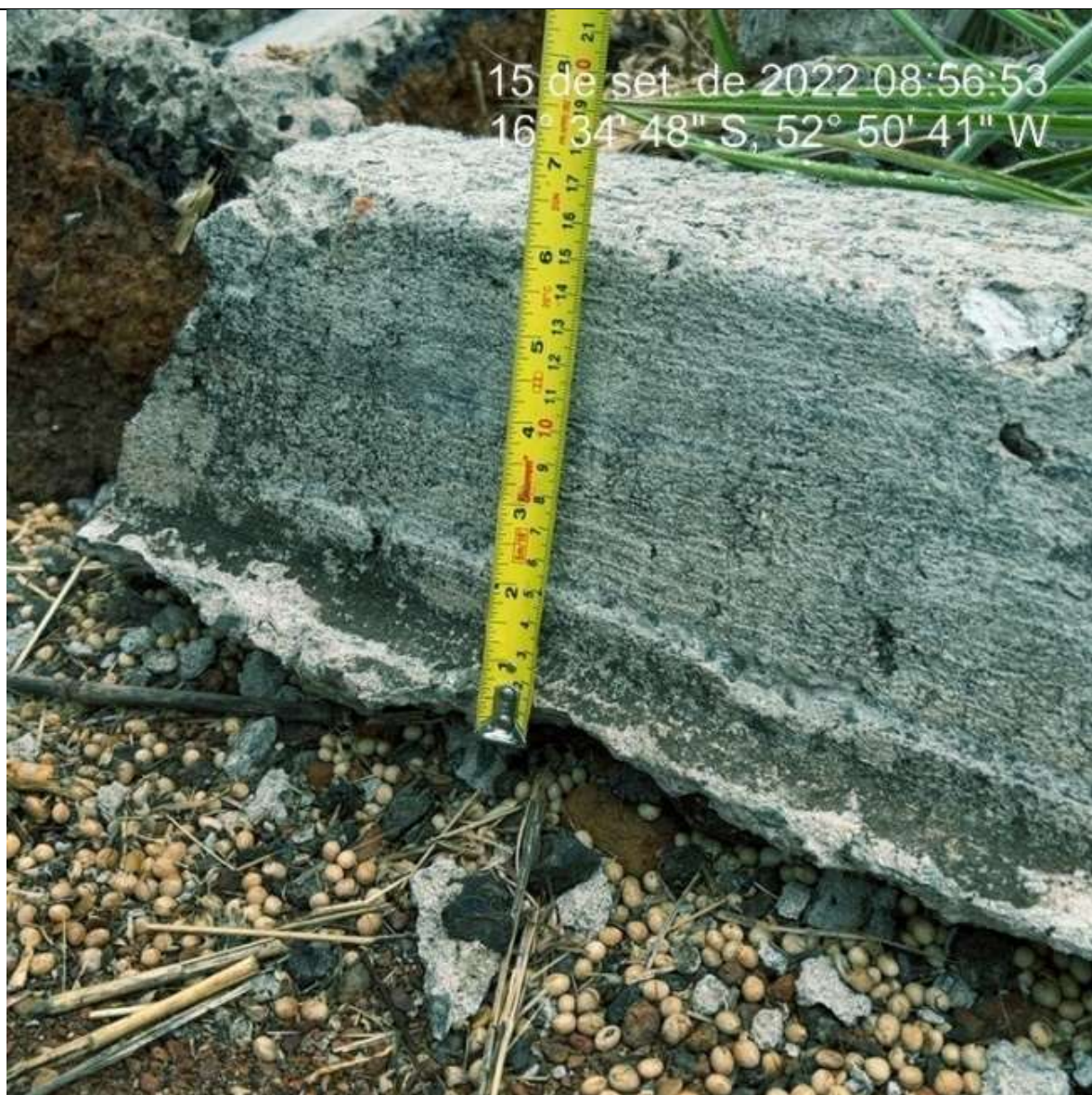
Imagem 3570. Altura inferior e 25cm definida no projeto. Ausência de sarjeta.
