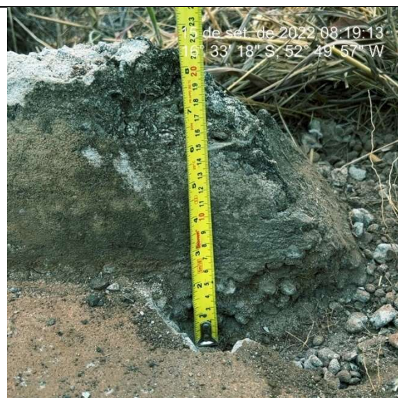
Imagem 3555. Altura inferior e 25cm, definida no projeto. Sarjeta com espessura inferior a 10cm definida no projeto.
