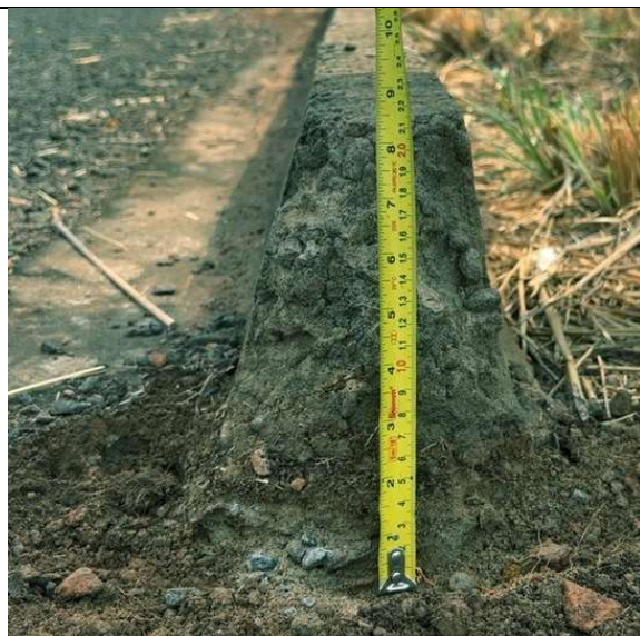
Imagem 3589. Altura inferior e 25cm, definida no projeto. Sarjeta com espessura inferior a 10cm definida no projeto.
