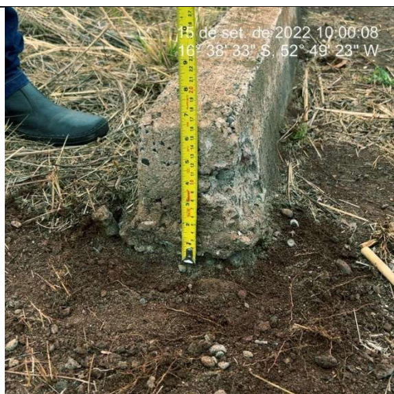
Imagem 3620. Altura inferior e 25cm definida no projeto. Ausência de sarjeta.
