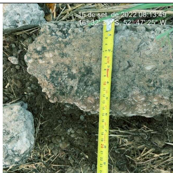
Imagem 3553. Altura inferior e 25cm, definida no projeto. Ausência de sarjeta.
