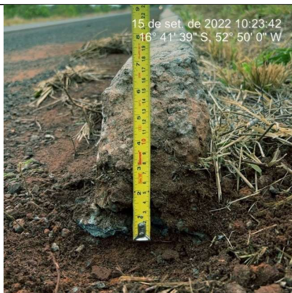
Imagem 3629. Altura inferior e 25cm definida no projeto. Ausência de sarjeta – meio-fio ancorado diretamente no acostamento de TSD.
