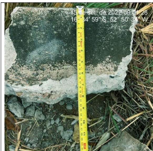
Imagem 3573. Altura inferior e 25cm, definida no projeto. Sarjeta com espessura inferior a 10cm definida no projeto.
