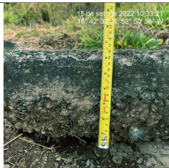
Imagem 3635. Altura inferior e 25cm definida no projeto. Ausência de sarjeta.
