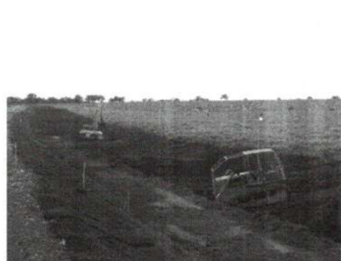
EXECUÇÃO DE RECOFORMAÇÃO EST. 1330
