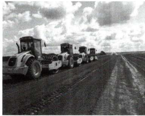
EXECUÇÃO SUB-BASE EST. 1310
