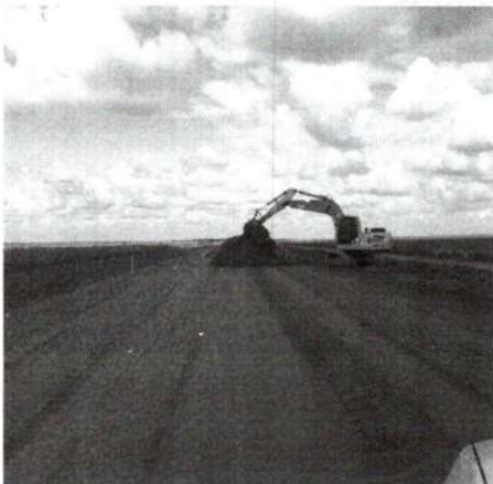
EXECUÇÃO DE BOTA DENTRO EST. 2850
