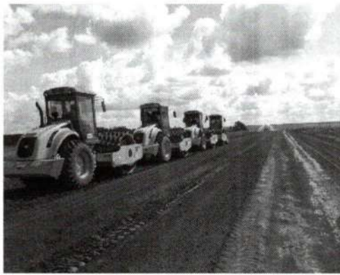
EXECUÇÃO SUB-BASE EST. 1310
