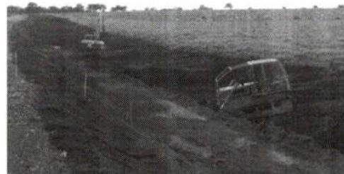
EXECUÇÃO DE RECOFORMAÇÃO EST. 1330
