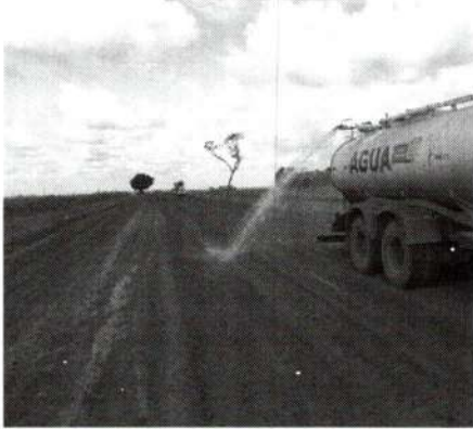
EXECUÇÃO SUB-BASE EST. 1310
