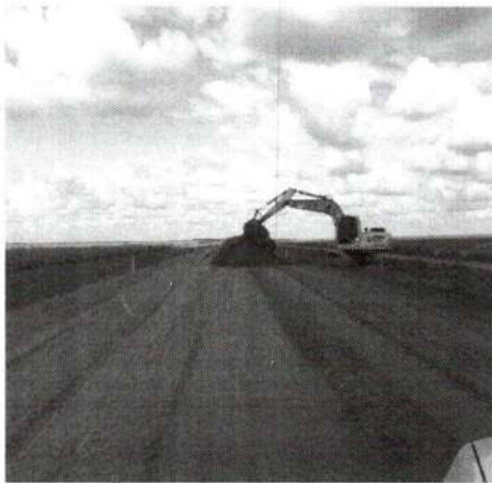
EXECUÇÃO DE BOTA DENTRO EST. 2850
