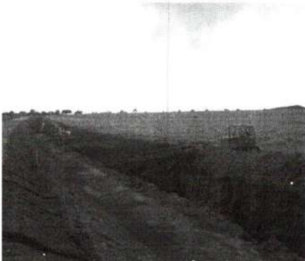
EXECUÇÃO DE RECOFORMAÇÃO EST. 1330
