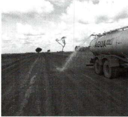
EXECUÇÃO SUB-BASE EST. 1310
