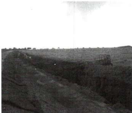
EXECUÇÃO DE RECOFORMAÇÃO EST. 1330
