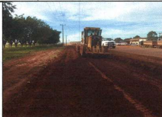
Coordenada: Localização: Serviço: 8.345.150 MT-336 EXECUÇÃO DE SUB TREVO MT-336/ MT-130 815.800
