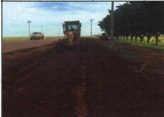
Coordenada: Localização: Serviço: 8.343.000 MT-336 EXECUÇÃO DE SUB TREVO MT-336/ MT-130 815.800
