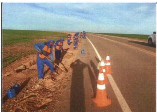
Coordenada: Localização: Serviço: 8.345.150 MT-336 PREPARO PARA EXECUÇÃO DE MEIO FIO 815.800
