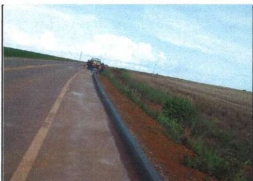
Coordenada: Localização: Serviço: 8.342.850 MT-336 EXECUÇÃO DE MEIO FIO 815.800
