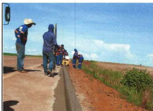
Coordenada: Localização: Serviço: 8.345.150 MT-336 EXECUÇÃO DE MEIO FIO 815.800
