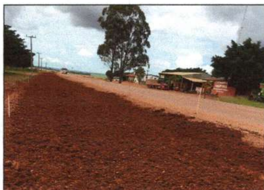
Coordenada: Localização: Serviço: 8.343.000 MT-336 EXECUÇÃO DE SUB BASE TREVO MT-336/ MT-130 815.800
