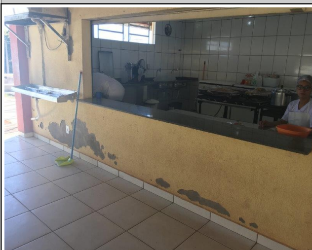
Foto 9 – Parede do refeitório com pintura danificada
