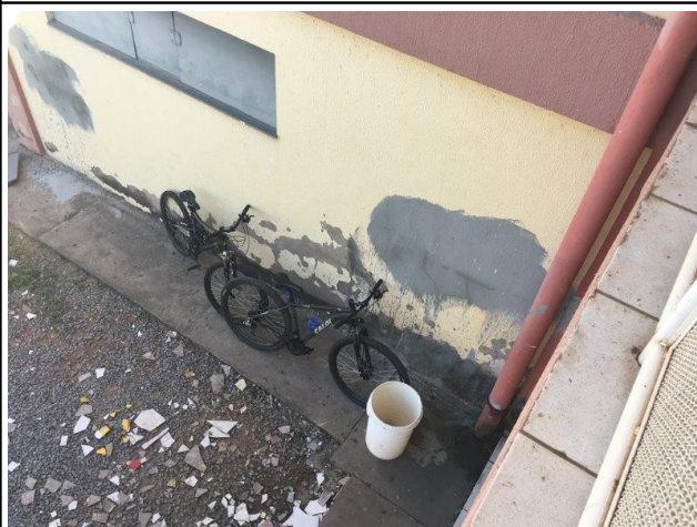
Foto 12 – Parede da fachada lateral com pintura danificada
