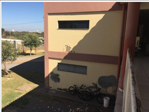
Foto 13 - Parede da fachada lateral com pintura danificada
