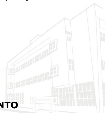
Edifício Marechal Rondon - Sede atual 2013
