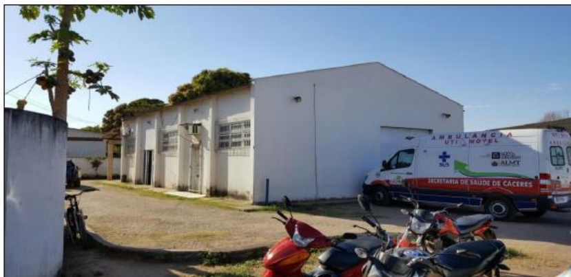
Foto 14 – Centro de Abastecimento Farmacêutico
