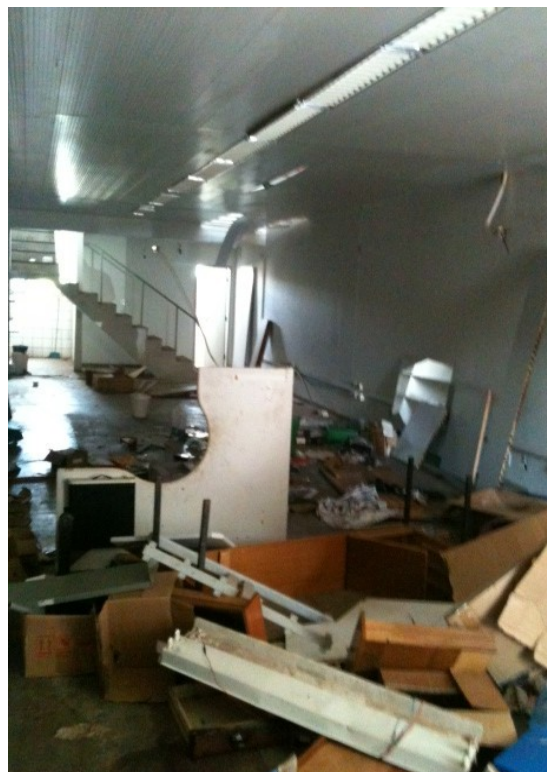
Foto 2 - salão do pavimento térreo
