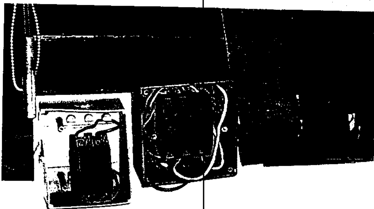
A combinação de fios com persianas só pode resultar em perigo, já que neste caso o fogo é iminente
