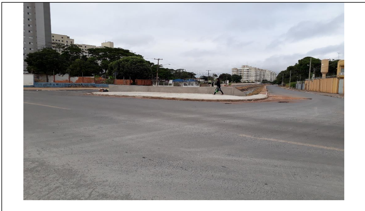
Foto 05 – Detalhe da Calçada
