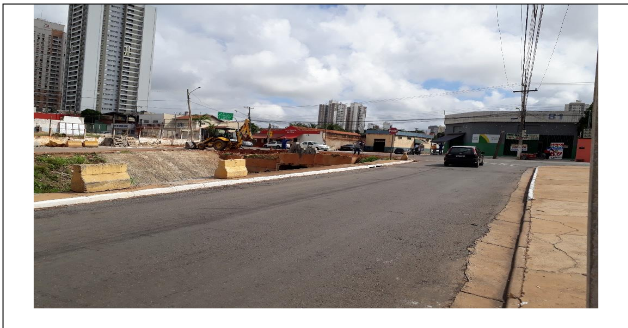
Foto 02 – Início dos Serviços de Acabamento (Mureta de Alvenaria / Calçada)
