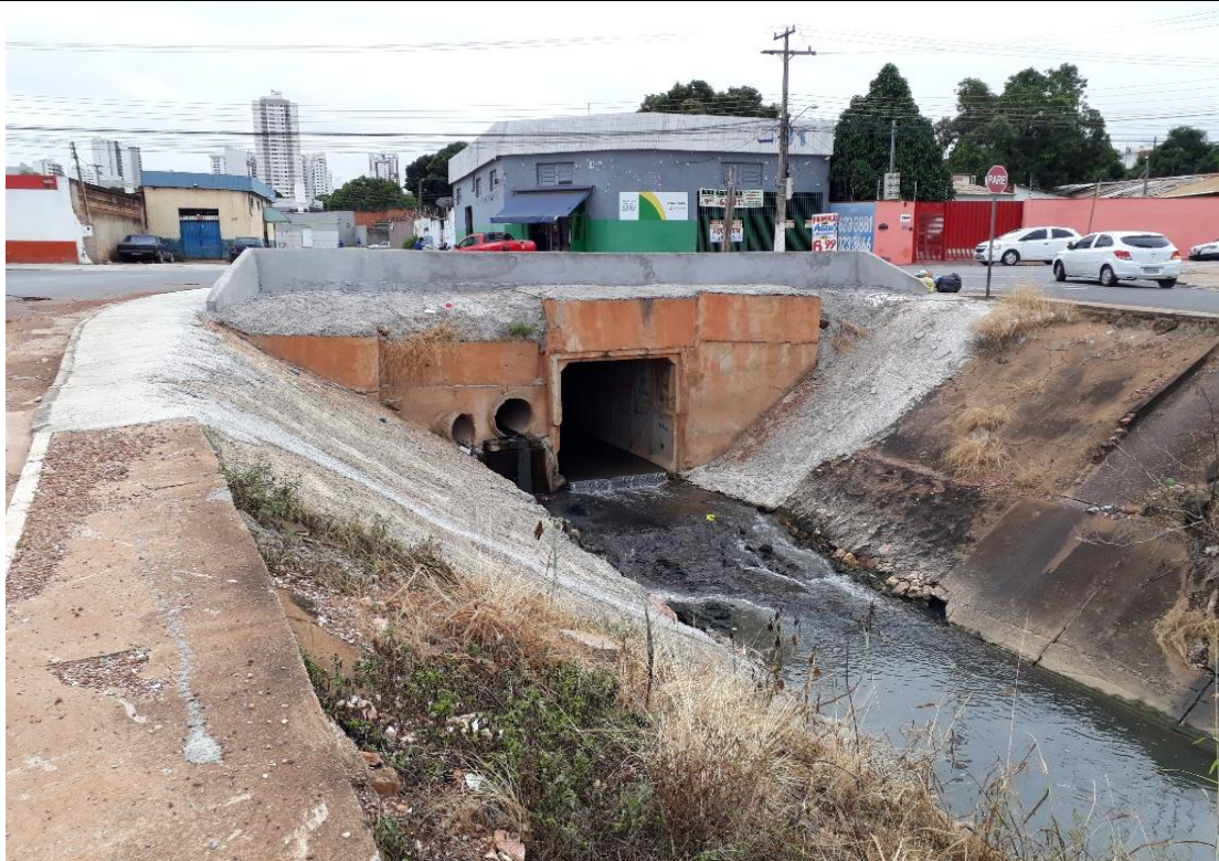
Foto 03 – Detalhe do Muro de Alvenaria
