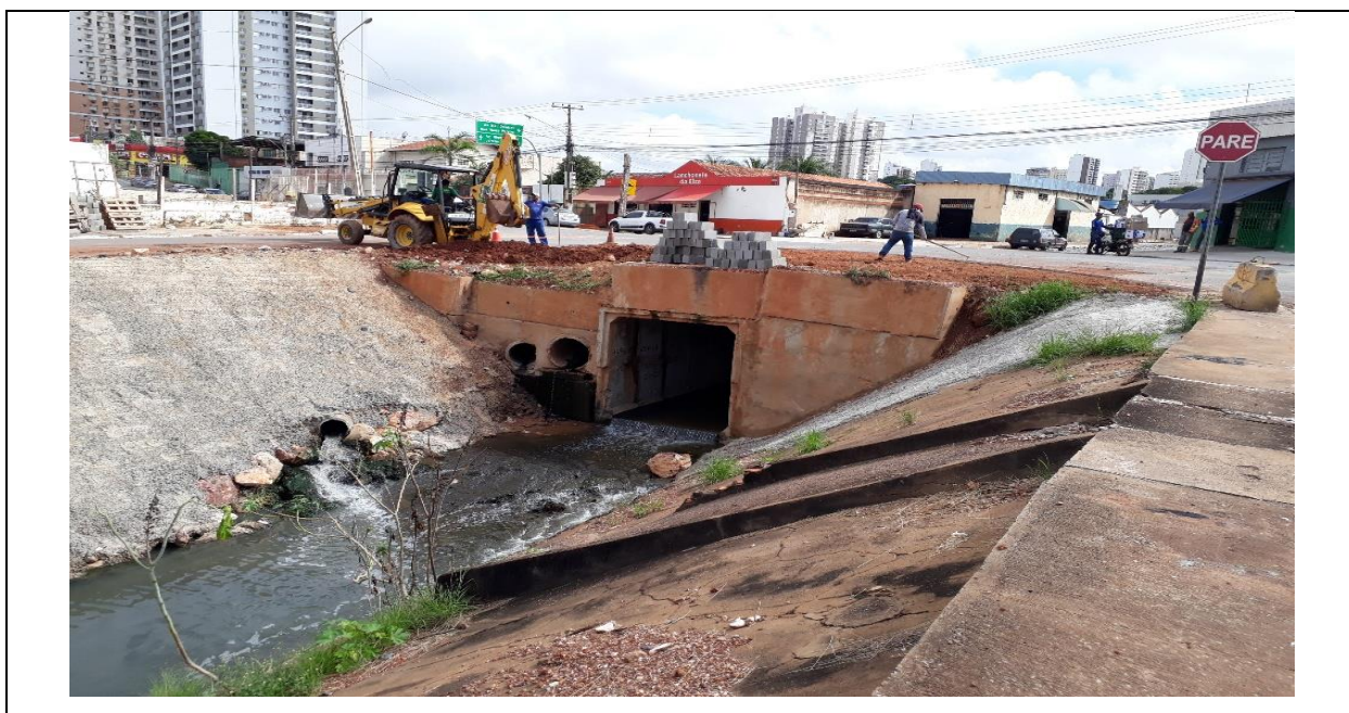
Foto 01 – Serviço de Recuperação da Lateral do Córrego
