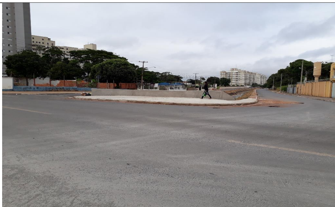
Foto 05 – Detalhe da Calçada
