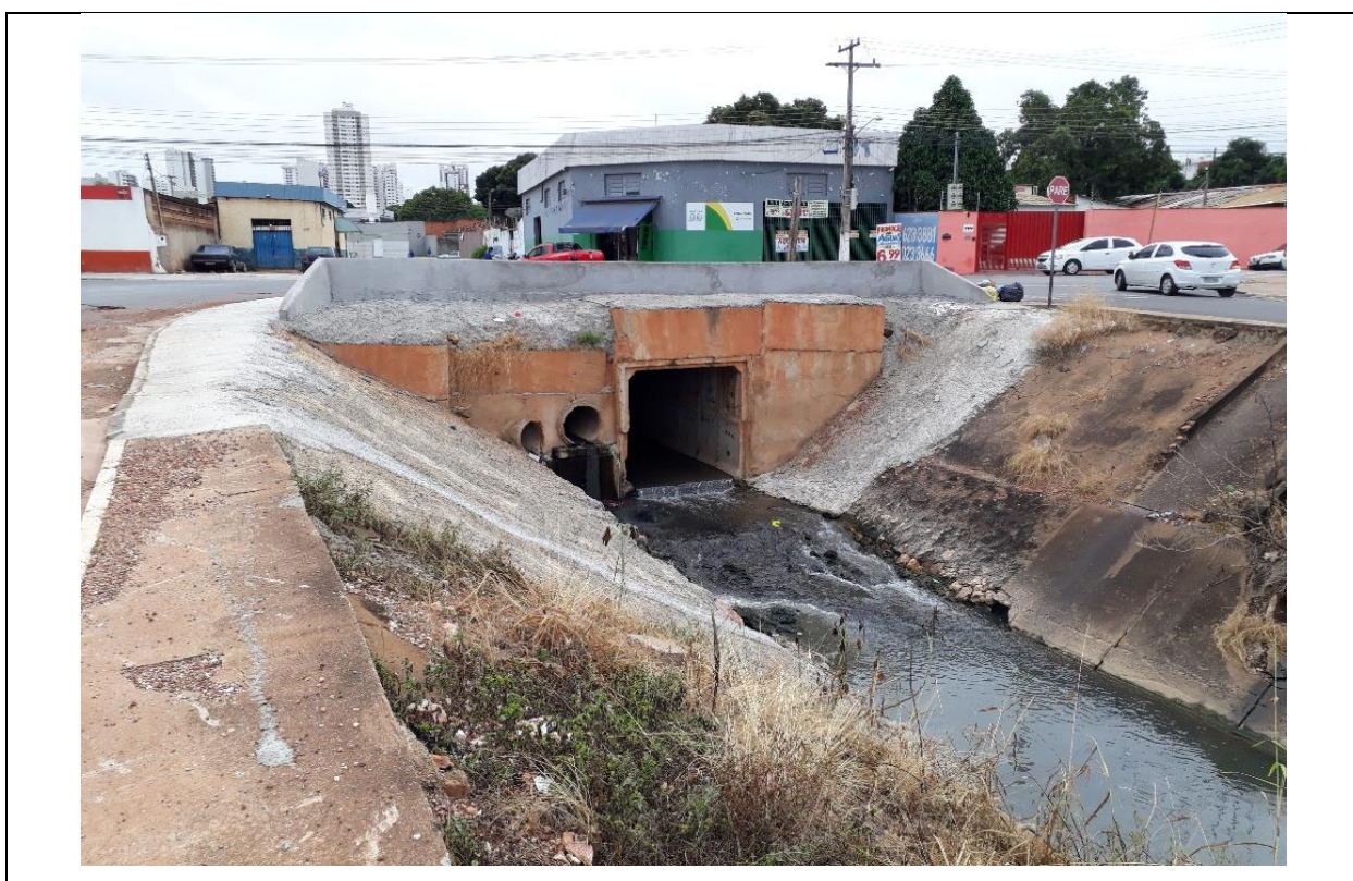
Foto 03 – Detalhe do Muro de Alvenaria
