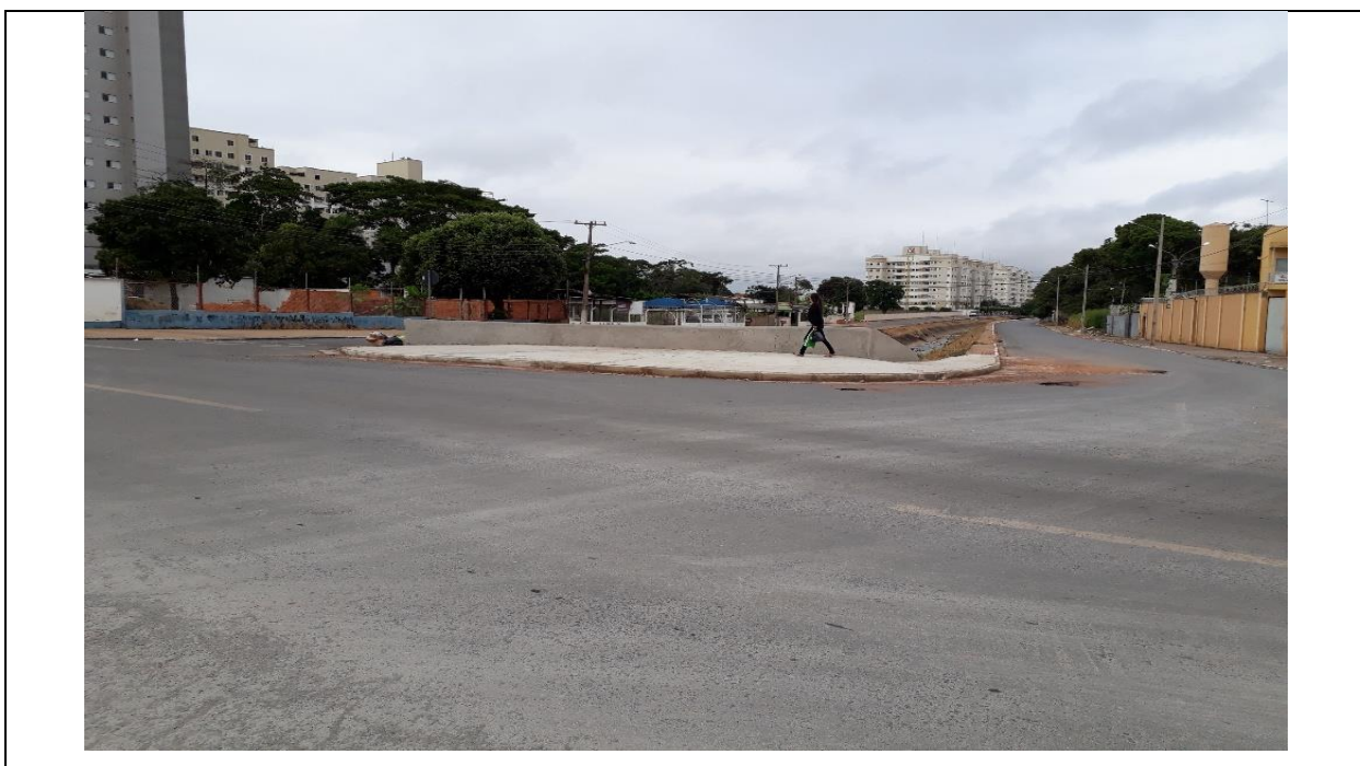
Foto 05 – Detalhe da Calçada
