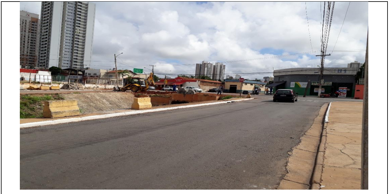
Foto 02 – Início dos Serviços de Acabamento (Mureta de Alvenaria / Calçada)
