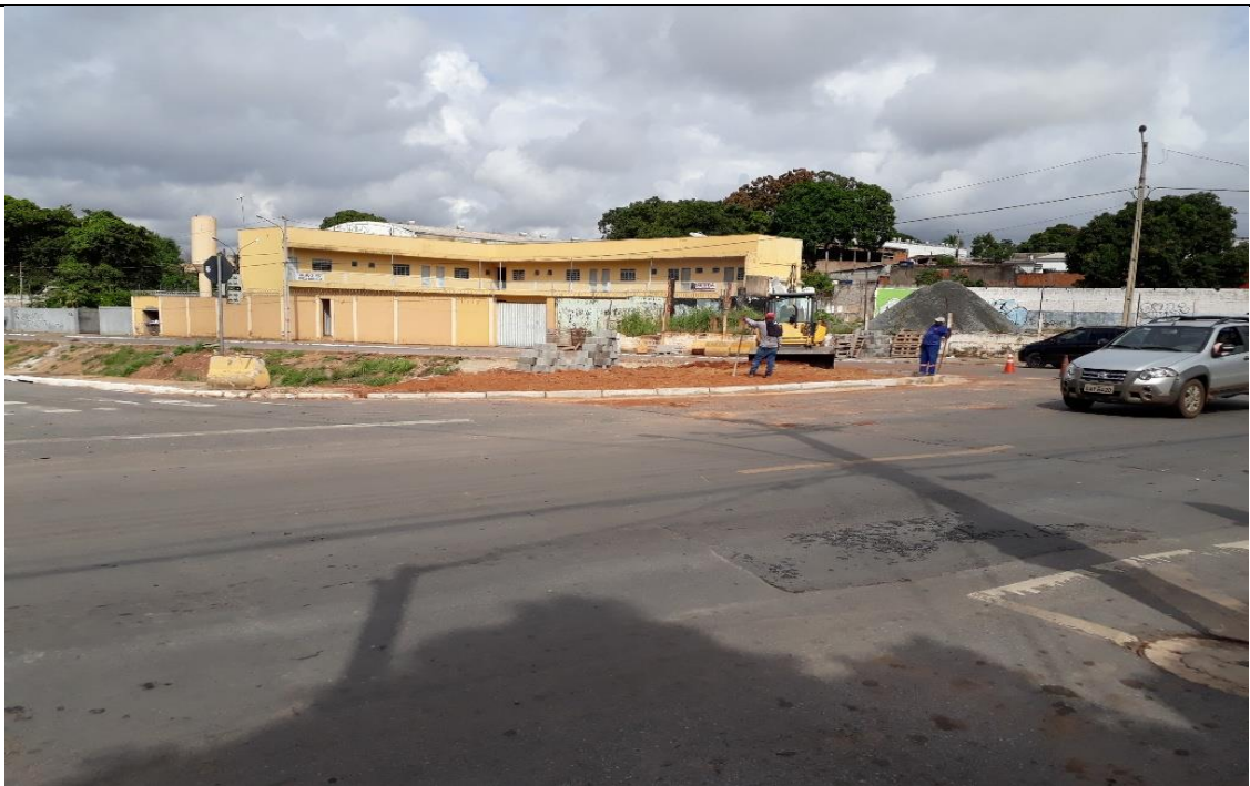
Foto 04 – Detalhe da Preparação do Contra Piso da Calçada
