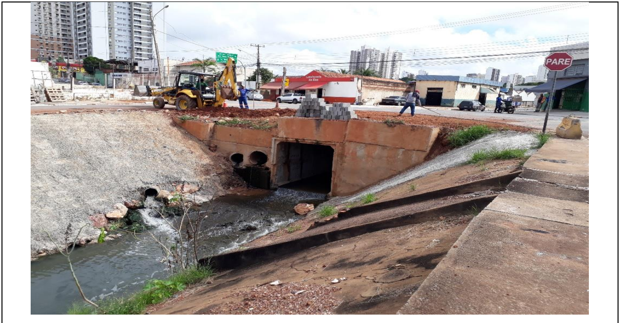
Foto 01 – Serviço de Recuperação da Lateral do Córrego
