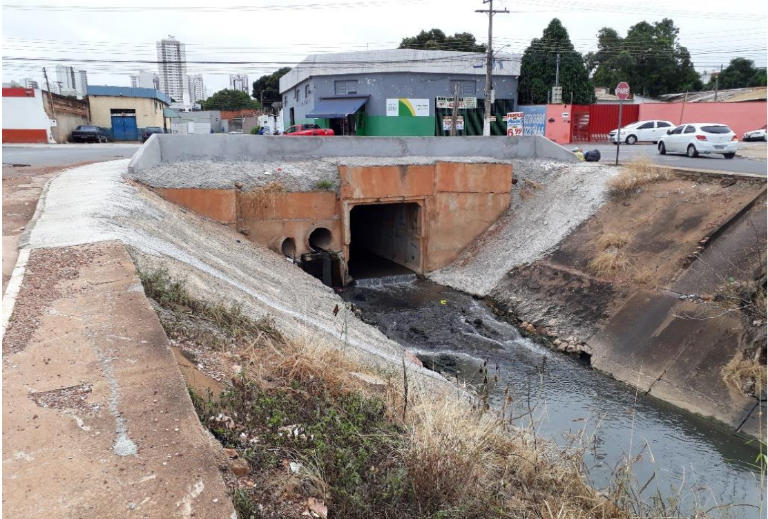
Foto 03 – Detalhe do Muro de Alvenaria
