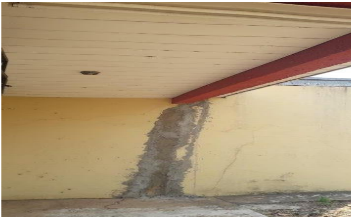
Rachaduras na parede
