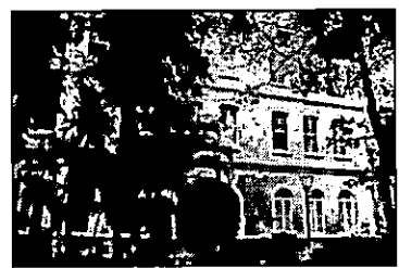
Edifício John Theron Mackenzie - Centro Histórico Mackenzie - Unidade São Paulo
