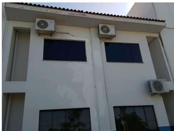
Falha na pintura
