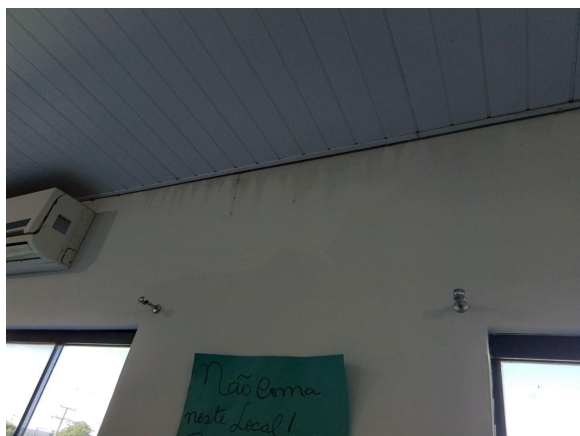
vazamento no teto
