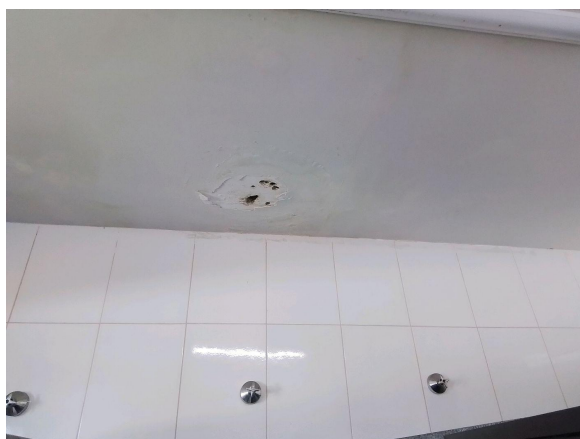
vazamento e infiltração
