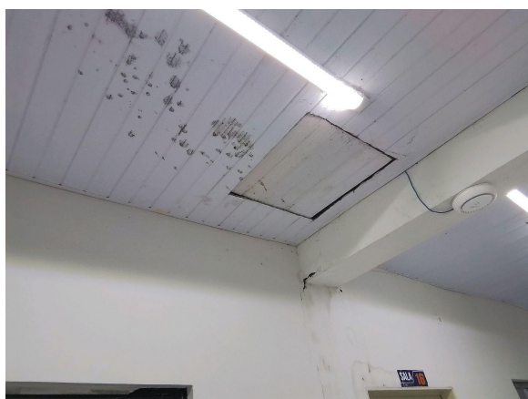
vazamento, fiação aparente e vandalismo
