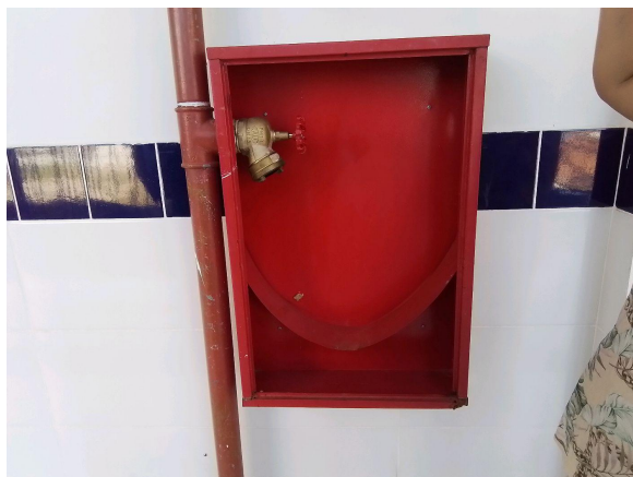
hidrante sem porta e sem mangueira
