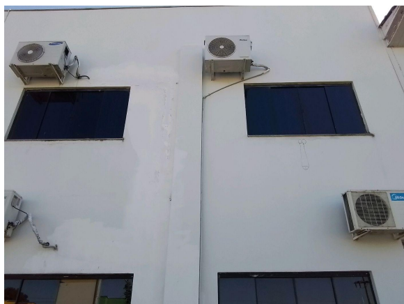
falha na pintura
