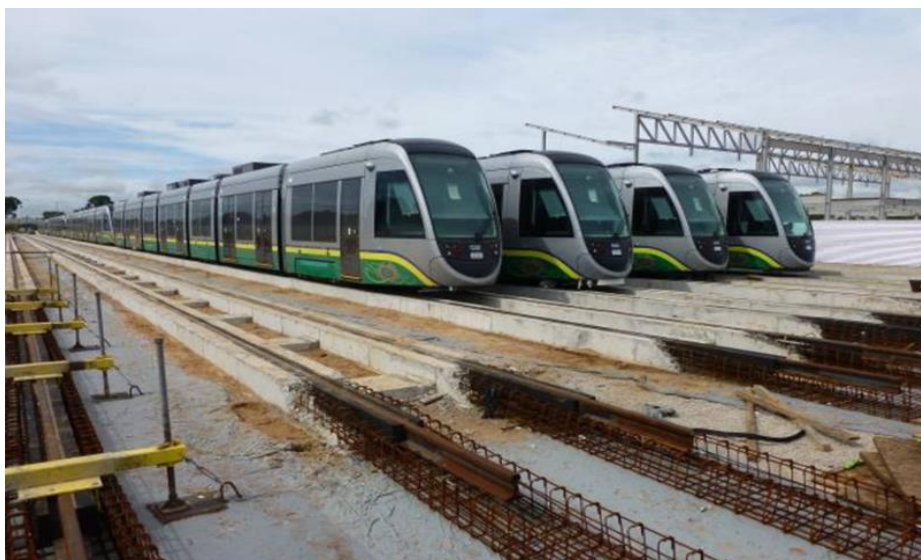
Figura 1 - Obra Veículo Leve sobre Trilhos - VLT. Contrato nº 037/2012.
