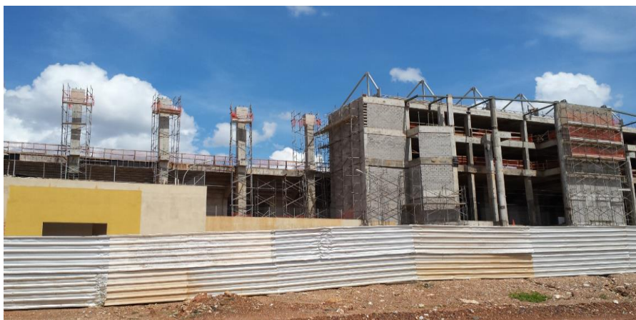
Centro Oficial de Treinamento (COT Barra do Pari), em novembro de 2014. Obra que se encontra paralisada desde dezembro de 2014
