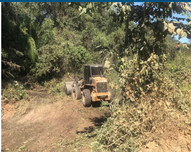
Foto 3 e 4. Construção de aceiro mecânico km 80 Transpantaneira – Município de Poconé
