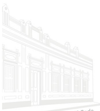
Casa da Câmara Municipal de Cuiabá - Sede
