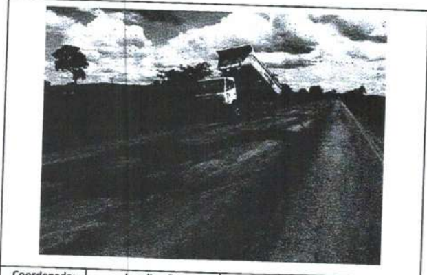
Coordenada: Localização: Serviço: MT - 175 TAPA-BURACO
