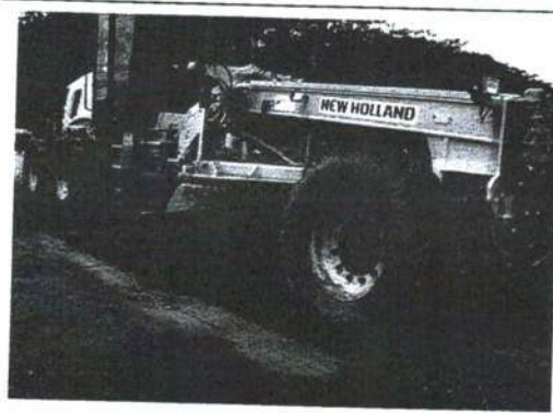
Coordenada: Localização: Serviço: MT - 175 PMF FRESAGEM
