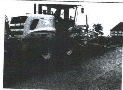
Coordenada: Localização: Serviço: MT - 175 PMF FRESAGEM
