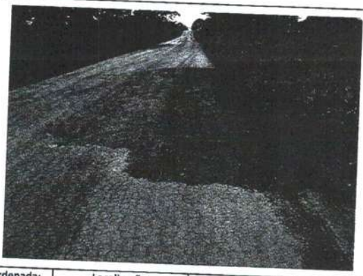
Coordenada: Localização: Serviço: MT - 175 TAPA-BURACO
