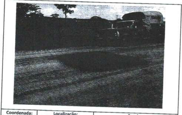
Coordenada: Localização: Serviço: MT - 175 TAPA-BURACO
