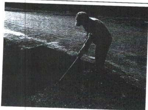
Coordenada: Localização: Serviço: MT - 175 TAPA-BURACO
