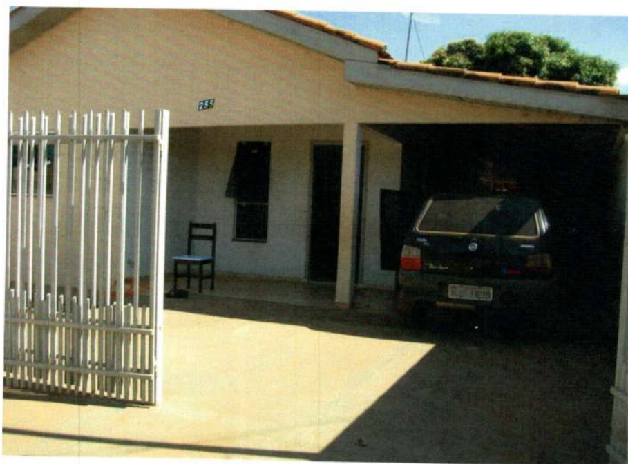
Canteiro: Escritório - Perímetro Urbano de S .J. de Quatro Marcos
