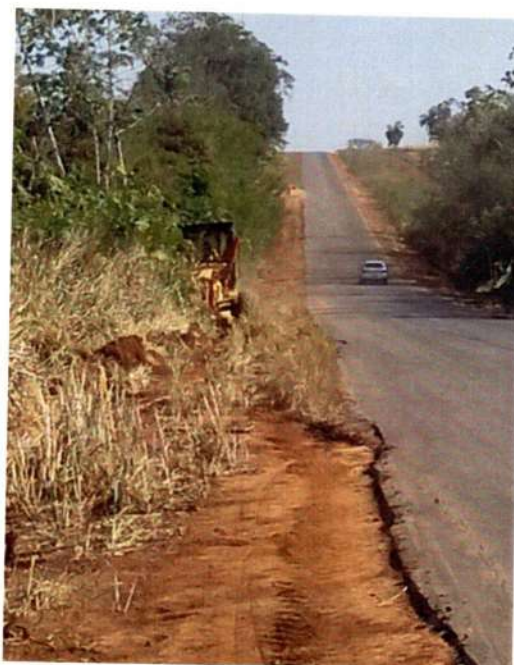
Limpeza de acostamento – Trecho Quatro Marcos / Araputanga
