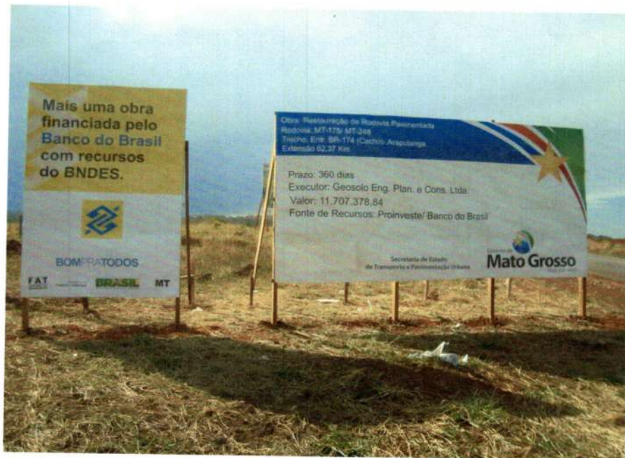
Placa de Obra – Entrª BR-174/MT175 (Cacho) – km 0,00
