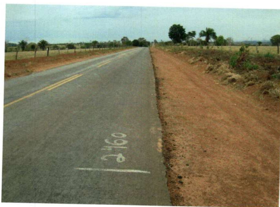
Limpeza de acostamento – Estaca 2460 – km 49,20
