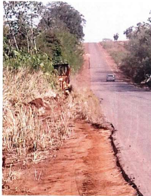
Limpeza de acostamento – Trecho Quatro Marcos / Araputanga
