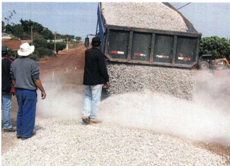
Reconfecção da Base com adição de 20% de brita. Est 1662
