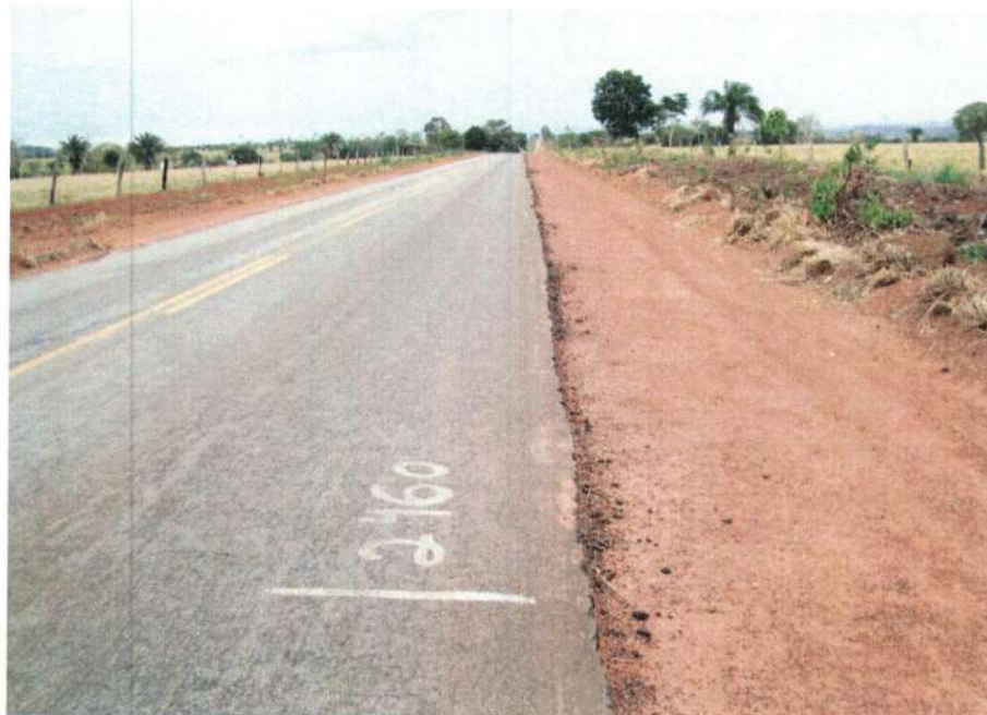
Limpeza de acostamento – Estaca 2460 – km 49,20
