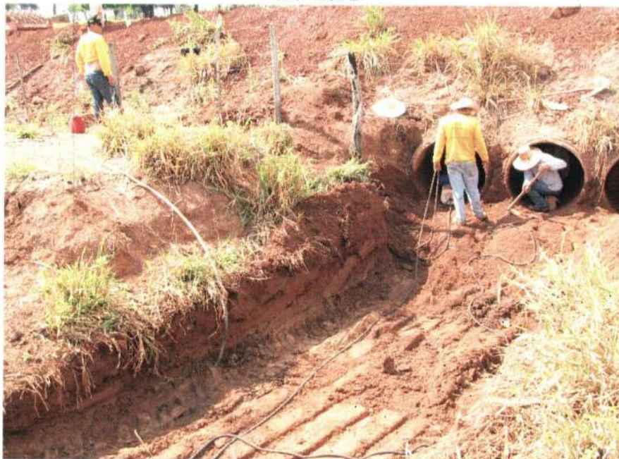
Limpeza de Bueiro Est - 1671
