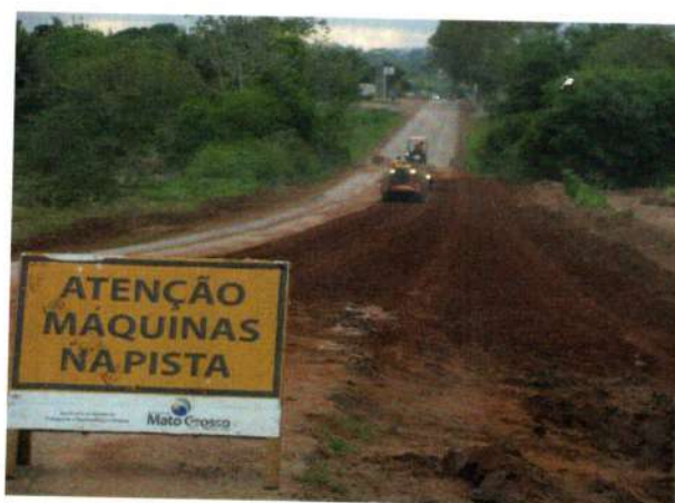
Reconfecção de base – compactação
