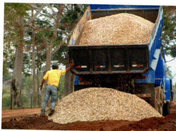
Adição de brita para reconfeção de base – est 1860
