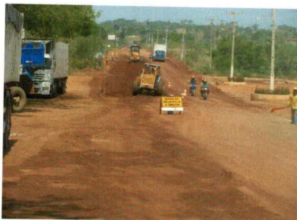
Reconfeção de base – estacas 1734 – 1742
