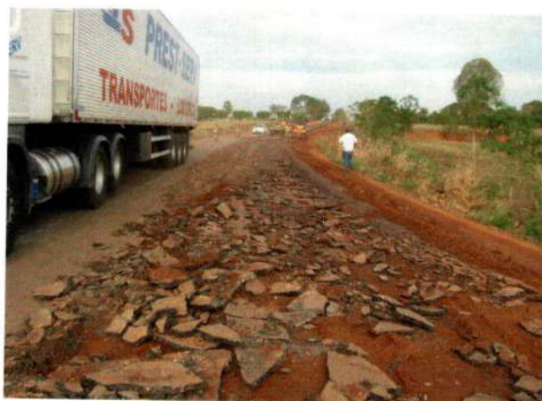
Remoção de revestimento betuminoso – est 1791 – 1831
