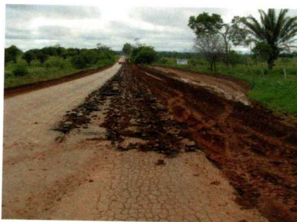
Remoção de revestimento betuminoso – estaca 1859-1869
