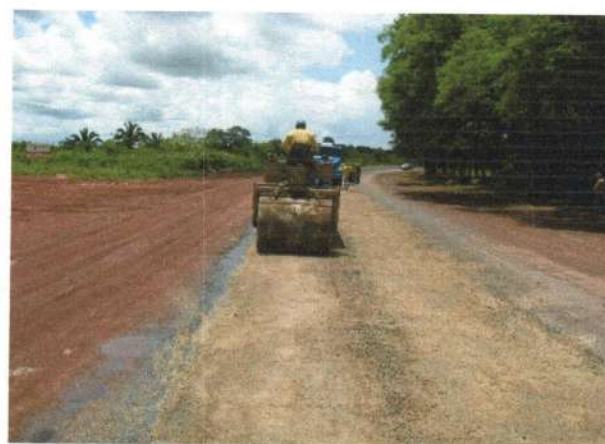
Execução de Capa Selante com Areia
