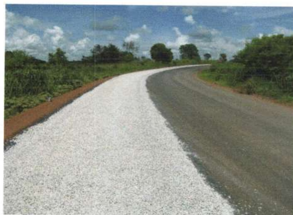
Execução de TSD
