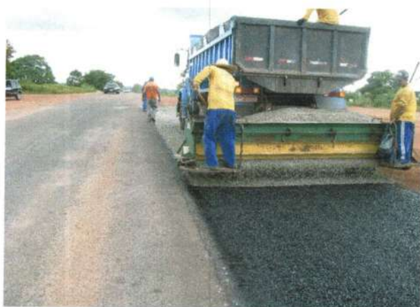
Execução de TSD
