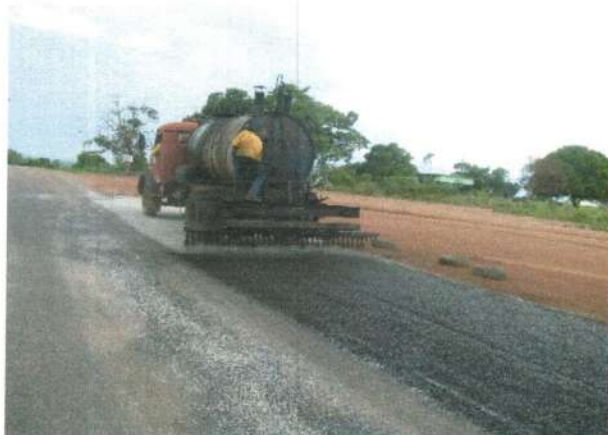
Execução de TSD
