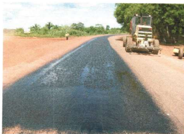
Execução de TSD
