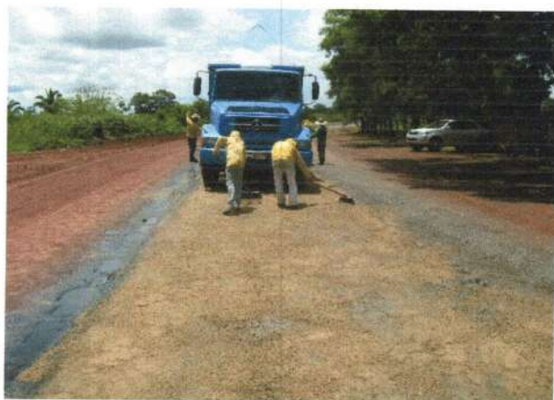
Execução de Capa Selante com Areia
