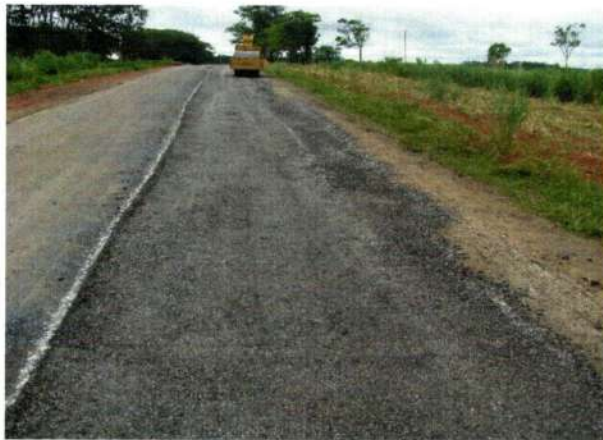
Reposição de PMF em fresagem
