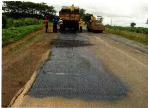
Reposição de PMF em fresagem
