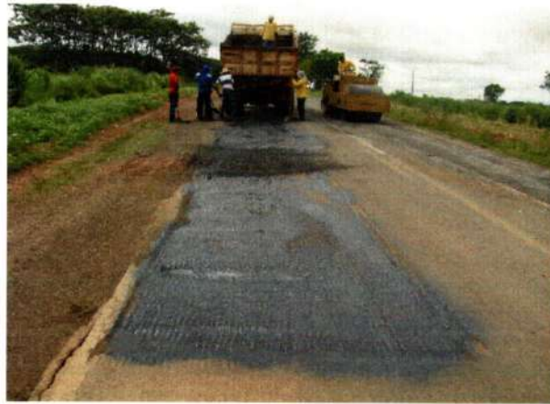
Reposição de PMF em fresagem
