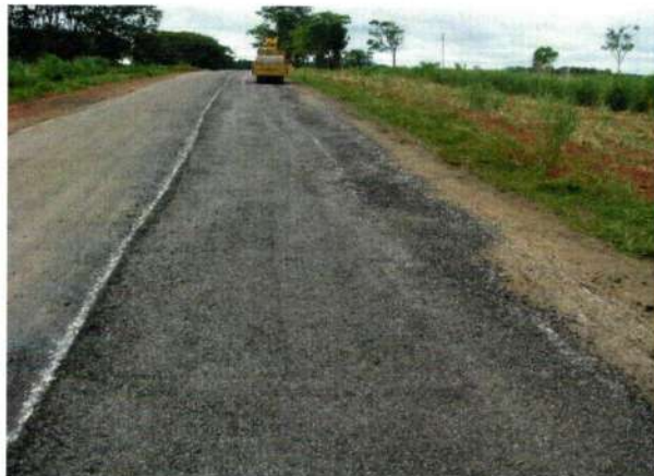
Reposição de PMF em fresagem
