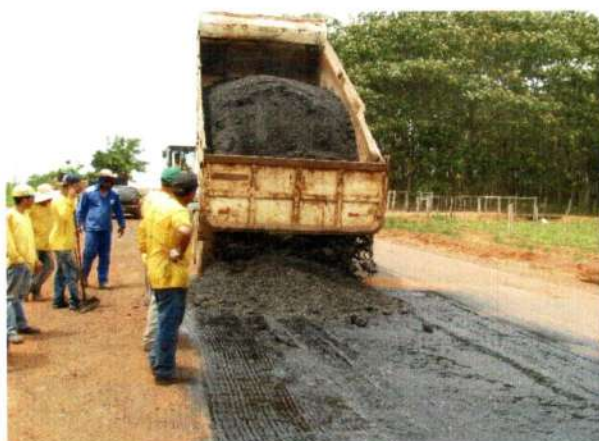
Pintura de Ligação e Reposição de Pavimento com PMF
