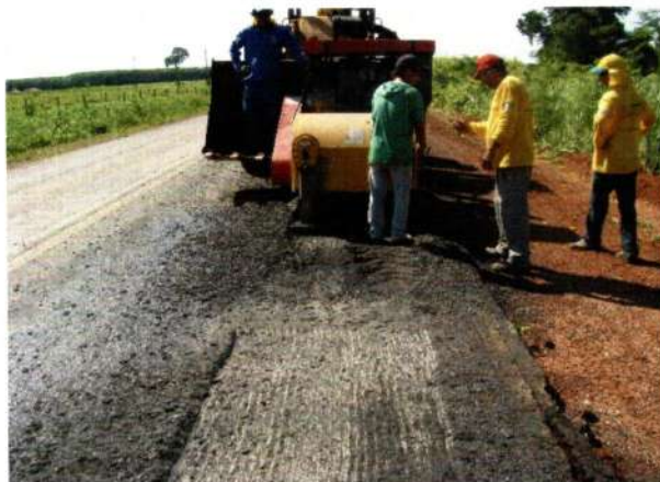
Detalhe de Frezagem
