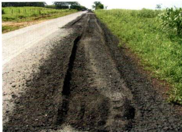
Detalhe de Frezagem
