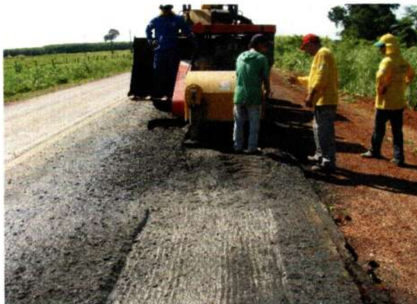
Detalhe de Frezagem
