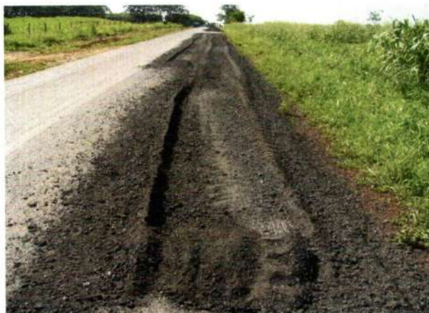
Detalhe de Frezagem
