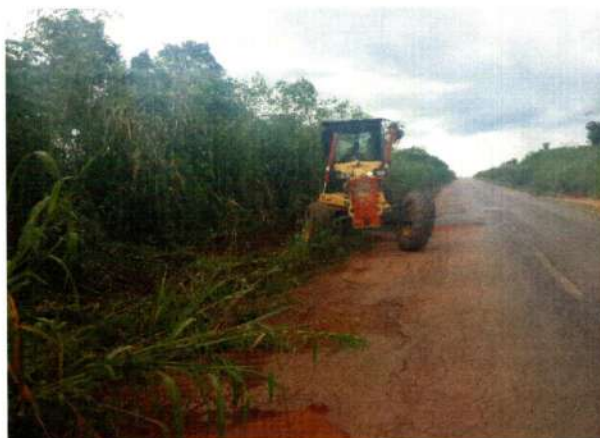
Limpeza de acostamento
