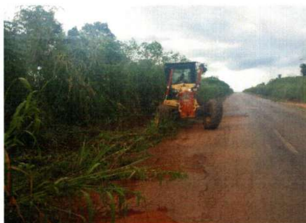
Limpeza de acostamento
