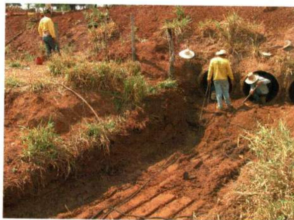
Limpeza de Bueiros
