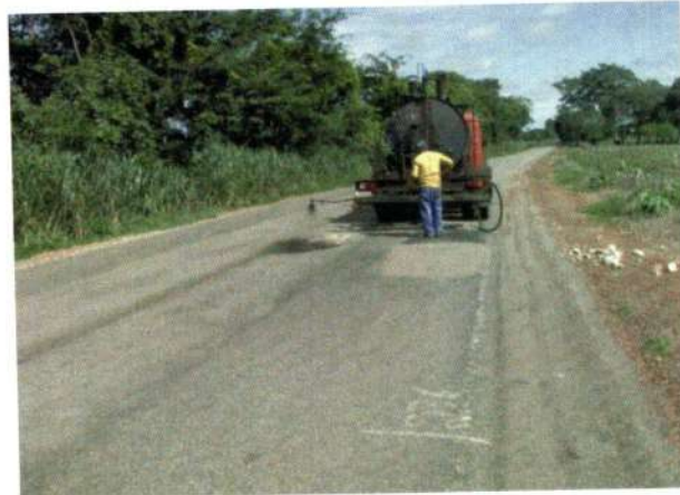
Pintura de Ligação em Tapa-buraco
