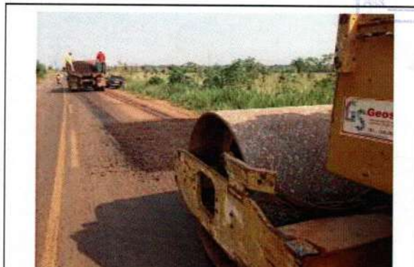
Atividade: Aplicação de PMF Rodovia: MT 175
