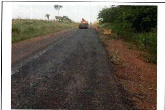
Atividade: Aplicação de PMF Rodovia: MT 175
