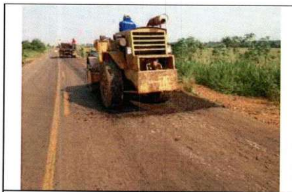
Atividade: Aplicação de PMF Rodovia: MT 175
