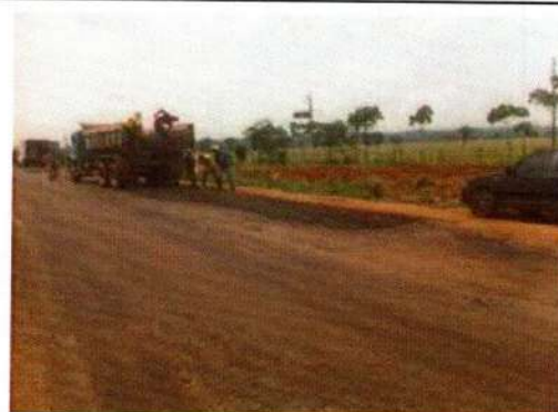
Atividade: Aplicação de PMF Rodovia: MT 175
