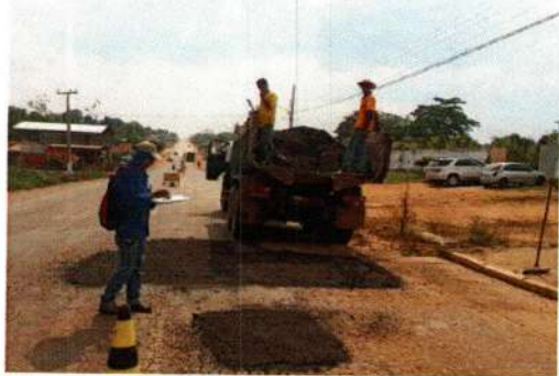
Atividade: Aplicação de PMF Rodovia: MT 175
