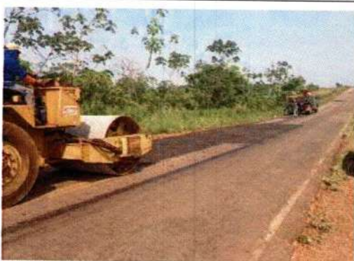
Atividade: Aplicação de PMF Rodovia: MT 175
