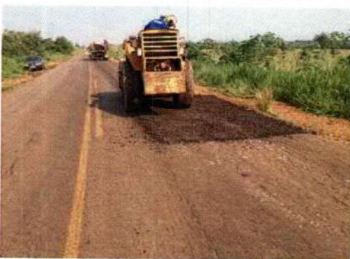
Atividade: Aplicação de PMF Rodovia: MT 175
