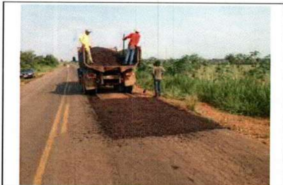
Atividade: Aplicação de PMF Rodovia: MT 175
