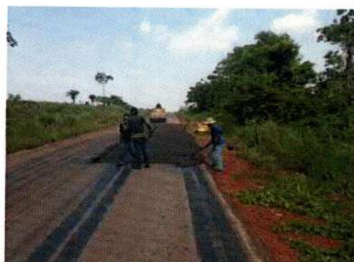
Atividade: Aplicação de PMF Rodovia: MT 175
