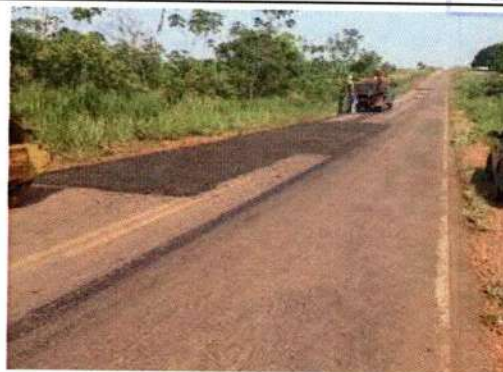
Atividade: Aplicação de PMF Rodovia: MT-175
