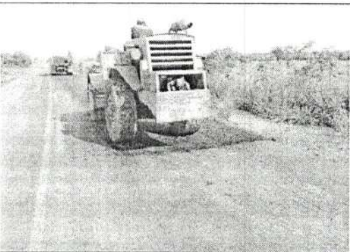
Atividade: Aplicação de PMF Rodovia: MT 175
