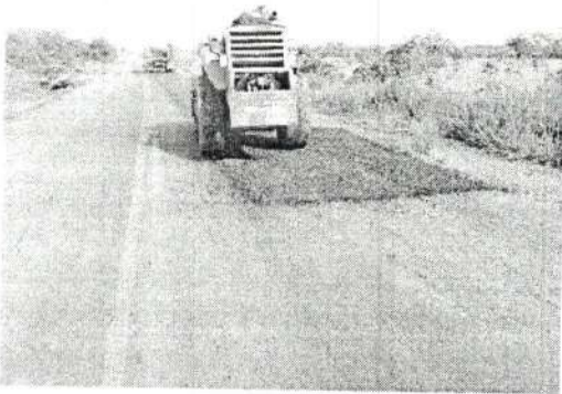
Atividade: Aplicação de PMF Rodovia: MT 175
