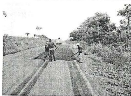
Atividade: Aplicação de PMF Rodovia: MT 175
