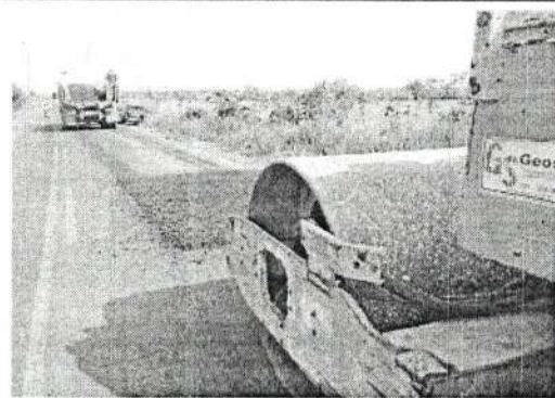
Atividade: Aplicação de PMF Rodovia: MT 175
