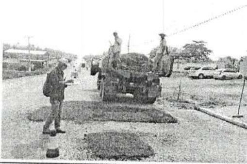
Atividade: Aplicação de PMF Rodovia: MT 175
