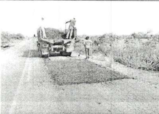
Atividade: Aplicação de PMF Rodovia: MT 175
