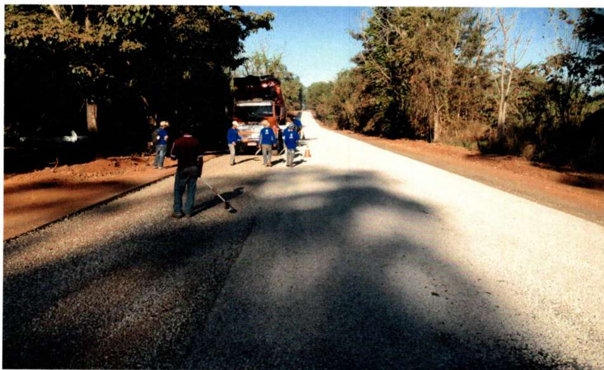
Serviço: Execução de capa TSD Local: 15º 29'7" S 58º 19' 57" O
