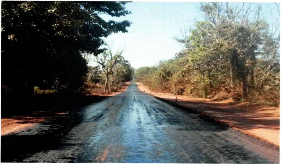
Serviço: Imprimação Local: 15° 29'7" S 58° 19' 57" O
