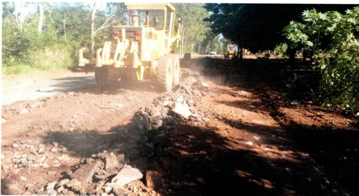
Serviço: Remoção do pavimento Local: 15° 29'7" S 58° 19' 57" O
