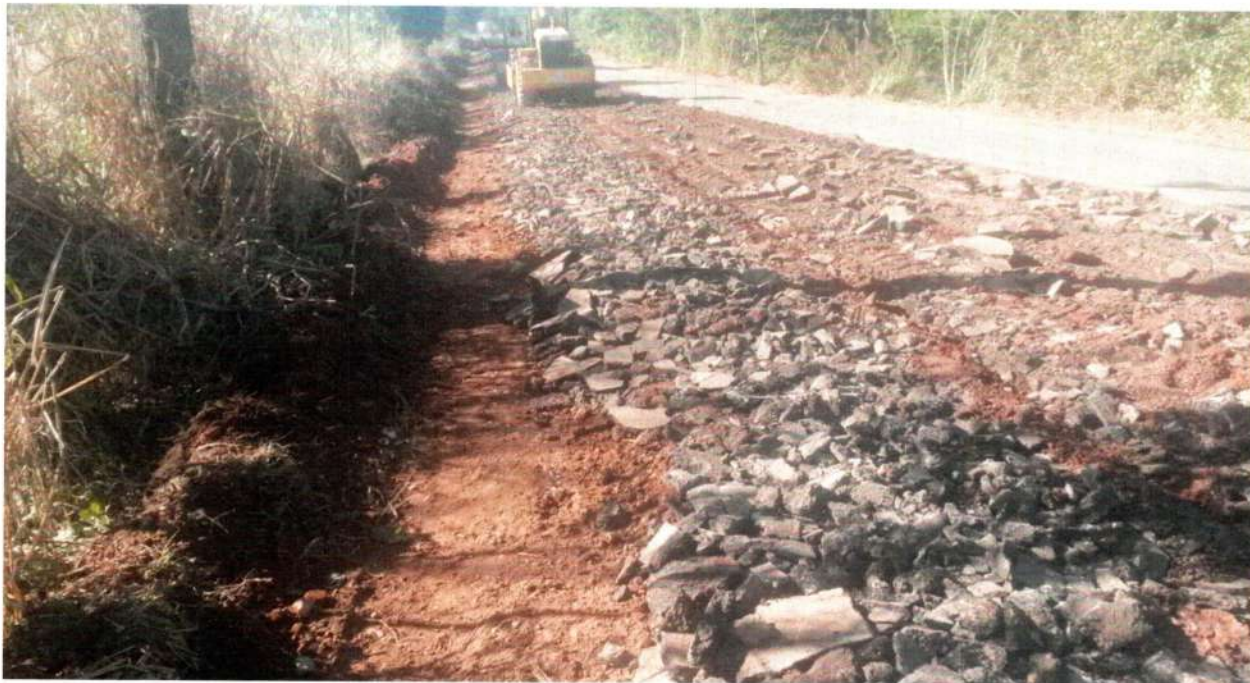
Serviço: Remoção do pavimento Local: 15° 29'7" S 58° 19' 57" O
