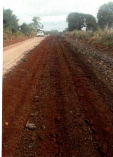
Serviço: Remoção do pavimento Local: 15° 29' 42" S 58 00 18' 48" S
