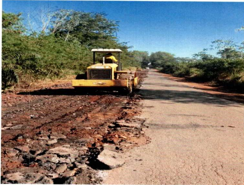
Serviço: Remoção do pavimento Local: 15° 29' 42" S 58 00 18' 48" S
