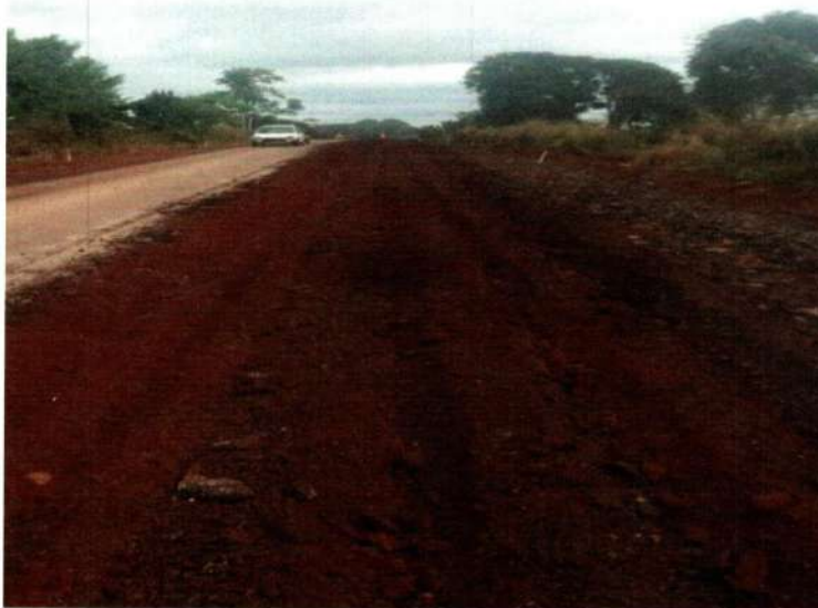
Serviço: Remoção do pavimento Local: 15° 29' 42" S 58ª 18' 48" S
