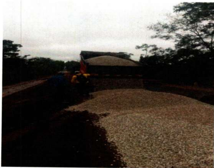
Serviço: Reconfeção de Base com adição de brita Local: 15°29'42"S - 58°18'48"W
