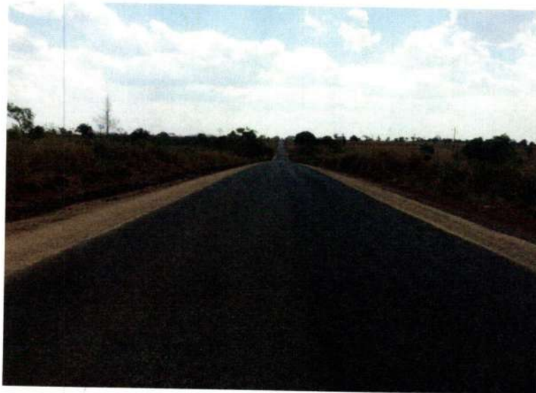
Serviço: Capa em TSD Local: 15°30'20"S - 58°17'26"W
