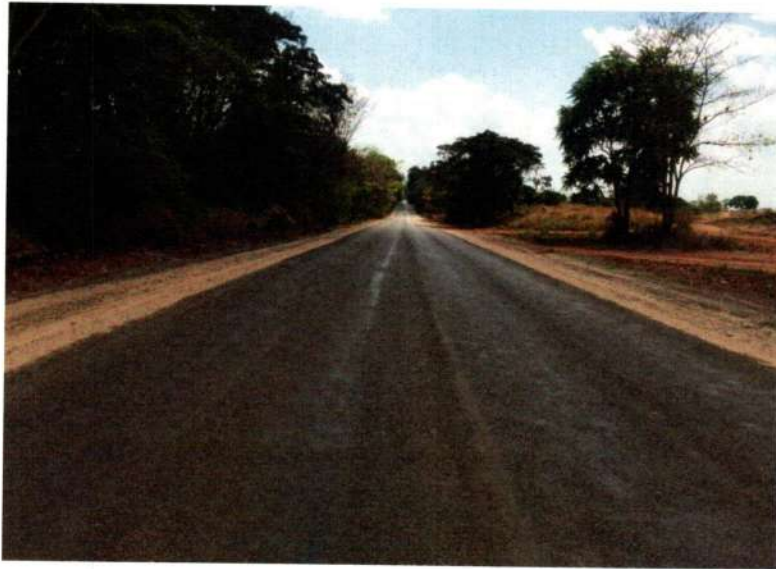
Serviço: Tratamento Superficial Duplo, após reconfeção de base Localização: 15°29'12"S – 58°10'44"W
