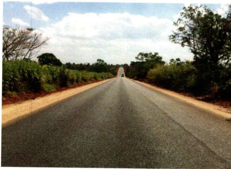
Serviço: Capa em TSD Local: 15°29'47"S - 58°18'34"W
